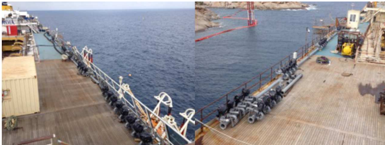
Sopra: posizionamento gruppi manifold per sistema di controllo della zavorra
