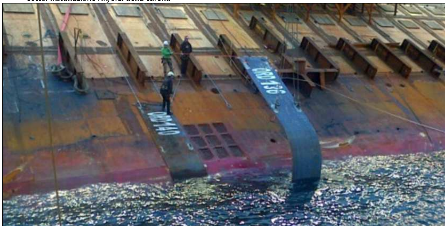
Sotto: installazione rinforzi della carena
