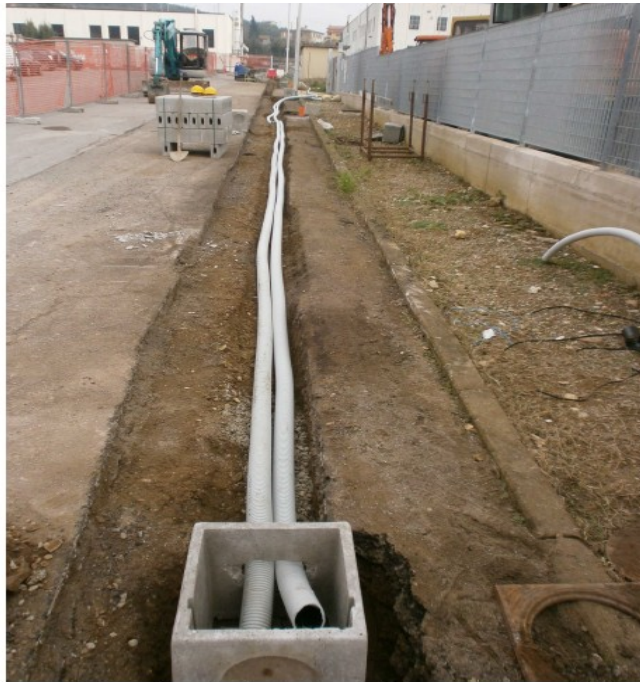
Foto 9: Canalizzazioni nuovi punti illuminazione pubblica
