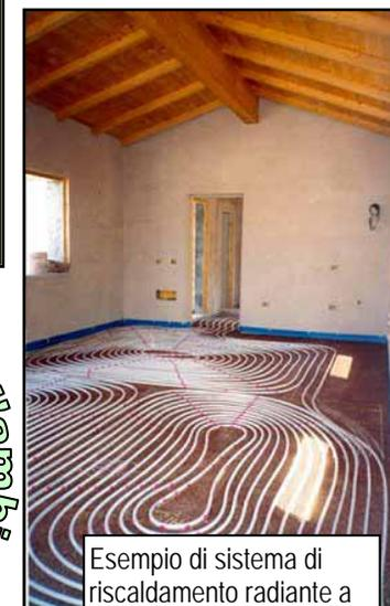
Esempio di sistema di riscaldamento radiante a pavimento in montaggio
