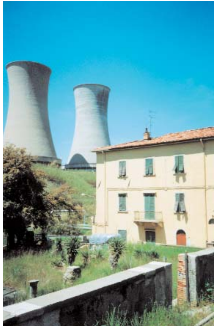
Foto 8 (1998) - L'edificio del Bagno al Morbo, presso Larderello, con le medievalmoderne torri di raffreddamento in disuso
