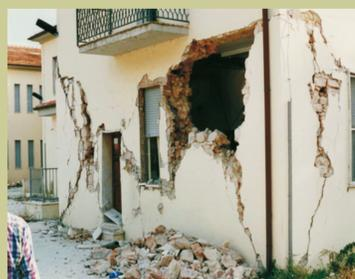
Lesioni sulle murature portanti o “**maschi murari**” a causa della **scarsa resistenza** della muratura.
