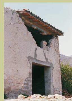
Le lesioni delle murature sono dovute alla **spinta orizzontale** dei travetti del solaio di copertura.
