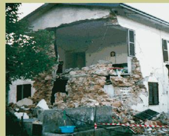
Danno provocato dalla **spinta** del solaio sulle pareti portanti se i collegamenti hanno scarsa efficacia.
