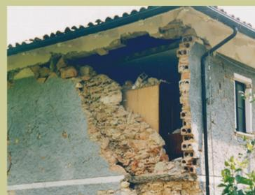
La **spinta** del puntone di copertura, in assenza di catene e/o tiranti provoca il **ribaltamento** dello spigolo.
