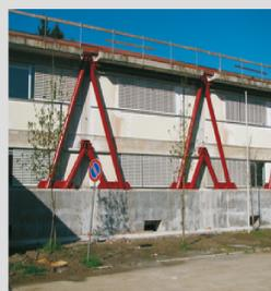
I **dissipatori**, realizzati con elementi metallici, sono collegati al telaio mediante barre passanti o per incollaggio con resine.
