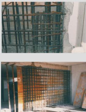
Per "stabilizzare" una struttura intelaiata è possibile inserire delle **pareti di controvento**, telai metallici o setti in c.a.
