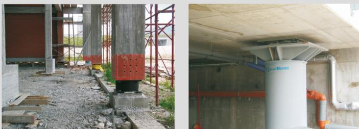
L'isolamento sismico è una tecnica che riduce gli effetti del sisma. Consiste nell'isolare gli edifici dal terreno, inserendo dei dispositivi d'appoggio, che permettono spostamenti orizzontali della struttura, senza che l'edificio subisca danni.
