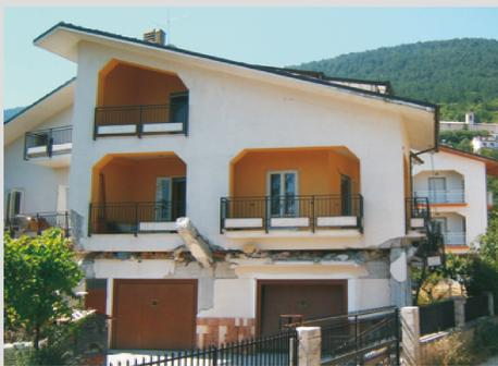
Il piano intermedio è schiacciato per effetto della rottura di tutti i pilastri del piano
