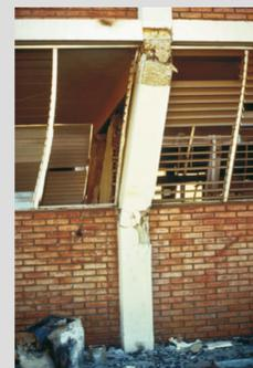
Rottura del pilastro reso “**tozzo**” dalle finestre lunghe “a nastro”.
