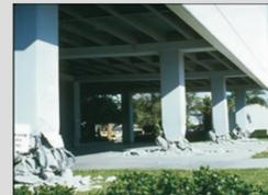
Meccanismo di danno **peggiore**. La rottura dei pilastri in prossimità dei nodi può portare fino al collasso della struttura.
