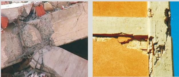
Le strutture in cemento armato sono caratterizzate da un comportamento sotto sisma con deformazioni prevalentemente concentrate alle **estremità dei pilastri e delle travi**, con eventuali rotture dei **nodi** o in prossimità degli stessi, in relazione ai quantitativi e alla disposizione delle armature.
