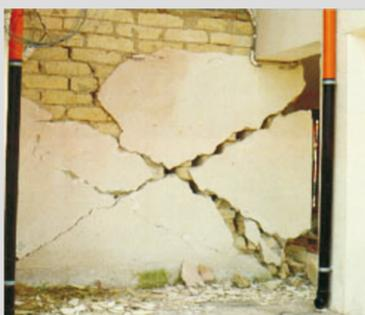
L'effetto indotto dalle tamponature è assimilabile al funzionamento di un puntone diagonale equivalente.
