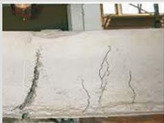
Meccanismo di danno **più favorevole**. La rottura delle travi in prossimità dei nodi non dovrebbe compromettere la stabilità della struttura.
