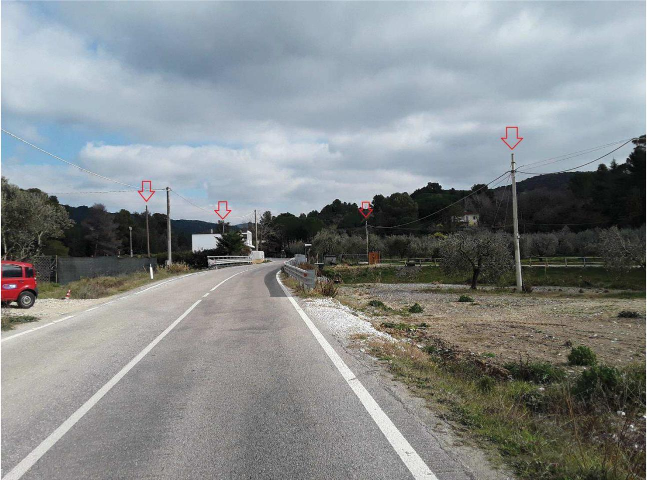
Per la rete di distribuzione aerea SP 8 altezza Via delle Fattorie rileviamo solo potenziali interferenze risolvibili con l'eventuale spostamento di pali ed inserimento di nuovi in asse con tiro fune e cavo della palificazione o interrimento con tubi predisposti da ambo le parti del ponte da concordare col progettista dell'opera.
