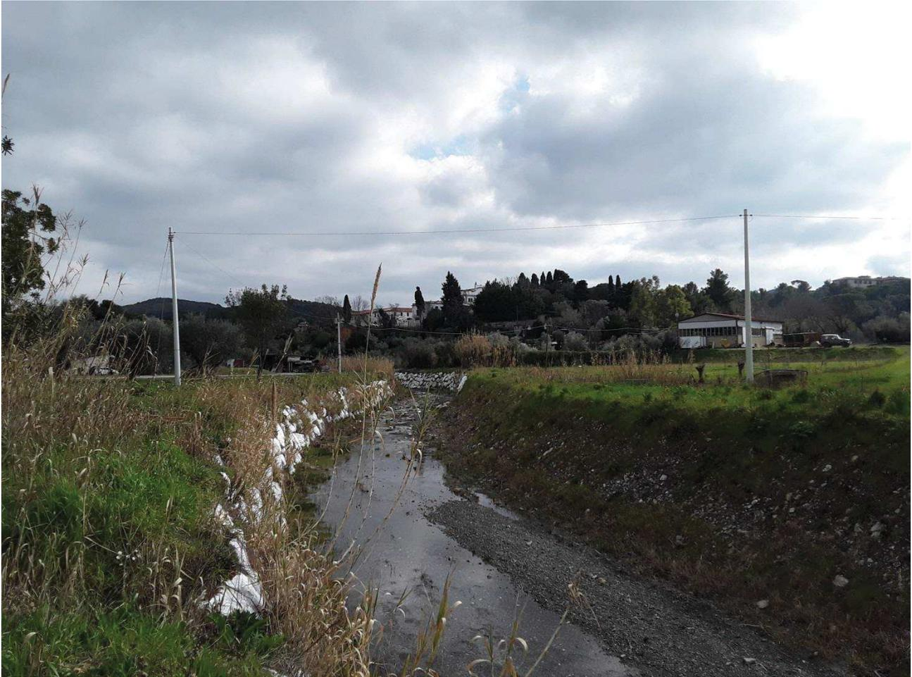
Per la rete di distribuzione aerea tra Via di Popogna e Via di S.Alò rileviamo solo potenziali interferenze, risolvibili con l'eventuale spostamento di pali ed inserimento di nuovi in asse con tiro fune e cavo della palificazione da concordare col progettista dell'opera.
