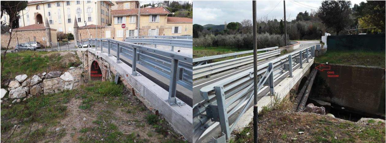
E' richiesto per entrambi i ponti in Via di Monterotondo la realizzazione di opportuna tubazione costituita da n. 2 tubi di diam. 125 ciascuno. In Fase di esecuzione per lo svolgimento dei lavori verrà utilizzato eventuale sostegno provvisorio in attraversamento e sostegno del cavo da concordare col progettista dell'opera.
