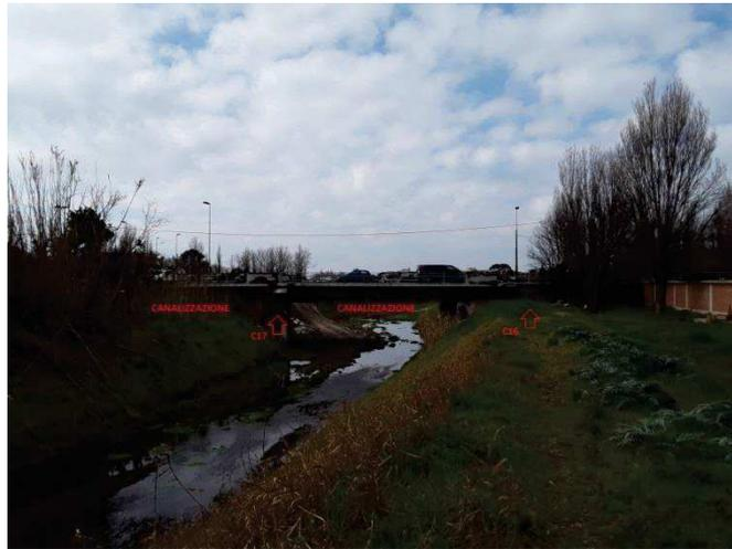
Entrambe le interferenze vengono risolte, in concomitanza con la deviazione del fosso Forcone con la realizzazione di una infrastruttura di bypass in tecnica no-dig (tratto rosso).
