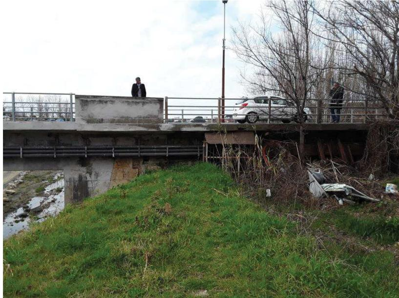
Come concordato in sede di conferenza ed in sede sopralluogo, è prevista nei lavori riguardanti il ponte il ripristino della canalizzazione oggetto di interferenza da cameretta C16 a C18 (costituita da n. 9 tubi di diam. 125mm) e cameretta intermedia di ispezione in sostituzione della C17.
