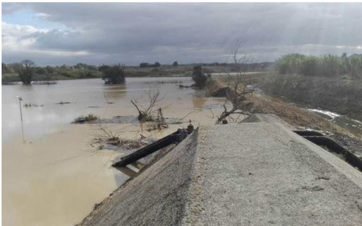
Figura 2: crollo delle arginature del T. Ugione in destra idraulica presso l'impianto idrovoro di "Ponte Ugione" in occasione dell'evento del 10 Settembre 2017
