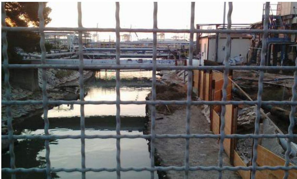
Figura 8: immissione del torrente Ugione nella darsena del porto; vista dal ponte su Via L. da Vinci
