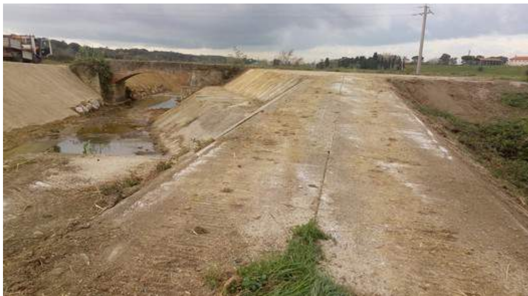
Figura 14: rivestimento dell'argine destro del T. Ugione presso il ponte di Via Aiaccia, dove l'argine trasversale D vi si innesta (vista da monte verso valle)
