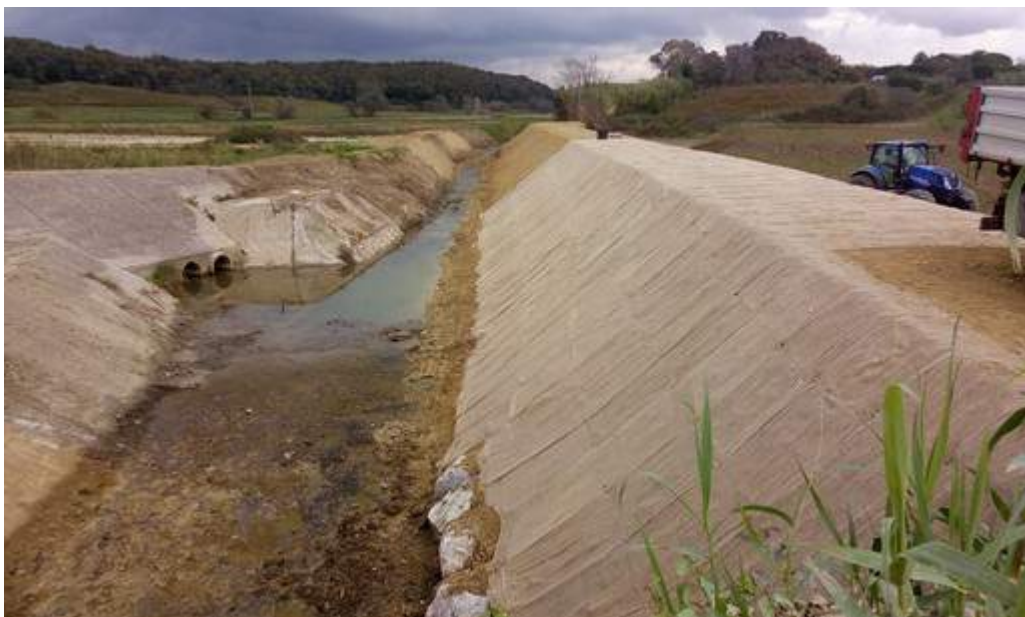
Figura 13: tratto dell'argine sinistro del T. Ugione a monte del ponte di Via Aiaccia a seguito dell'intervento in somma urgenza dopo l'evento del 10 settembre 2017 (vista da valle verso monte)
