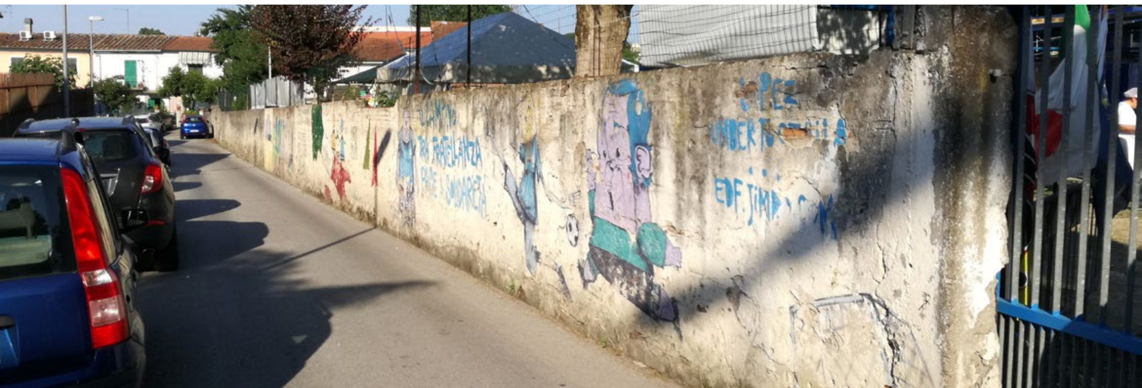
Muro perimetrale "Il Campino" - La Rotta, Pontedera
