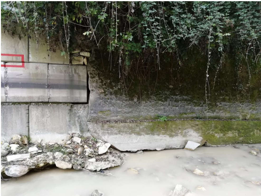
Foto in data 27.09.2019 del tratto iniziale del muro con scalzamento al piede
