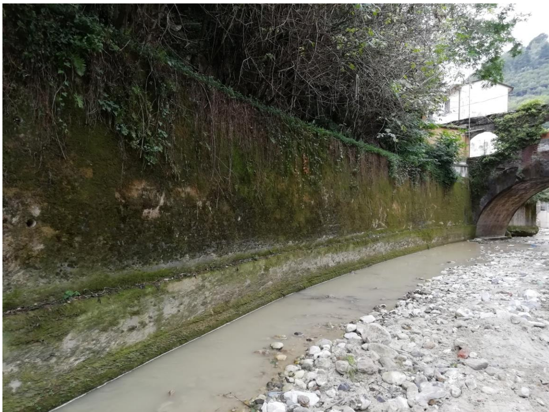
Foto in data 27.09.2019 del tratto del muro esistente senza spaccature con scalzamento al piede (cordolo di controfondazione)
