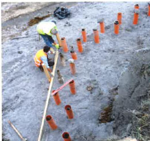
In fase di perforazione lo spessore della copertura alluvionale/riporto è stata rilevata dell'ordine di 1,7-1,8 metri.
