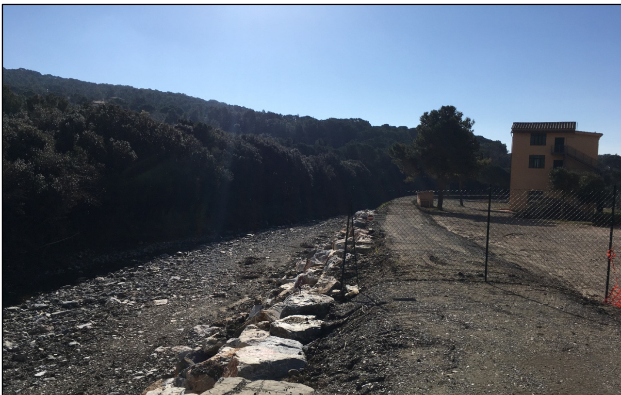
FOTO50.INTERVENTO 13 – AREA DI REALIZZAZIONE DELLA RAMPA DI ACCESSO ALL’ALVEO - VISTA DA MONTE
