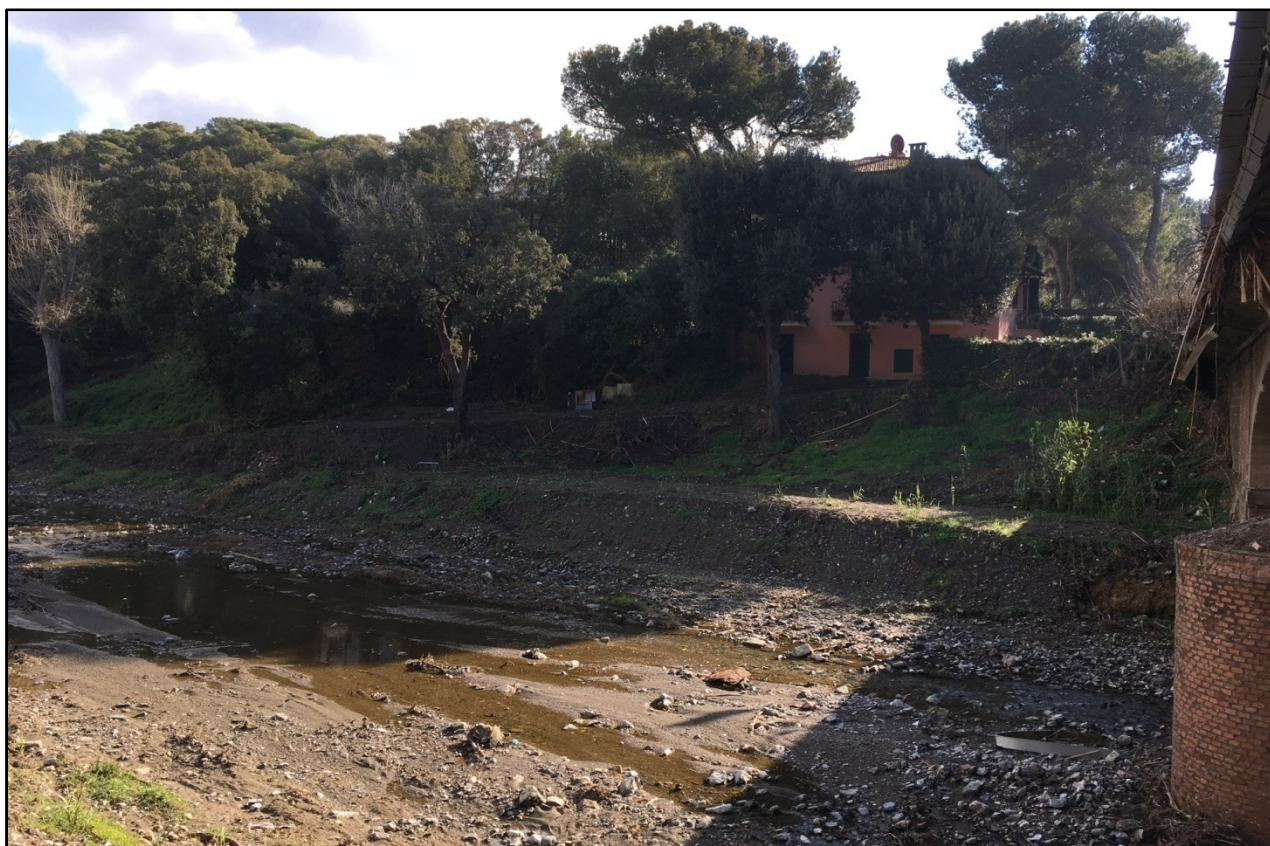
FOTO52.INTERVENTO 13 – AREA DI REALIZZAZIONE DELLA SCOGLIERA - VISTA DA VALLE DALL'ARGINE DESTRO
