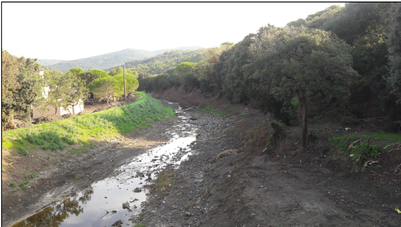
FOTO51.INTERVENTO 13 – AREA DI REALIZZAZIONE DELLA SCOGLIERA - VISTA DA VALLE DAL PONTE DELLA VIA AURELIA
