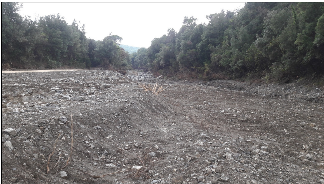
FOTO48.INTERVENTO 11-AREA DI REALIZZAZIONE DELLA SCOGLIERA - VISTA DA MONTE
