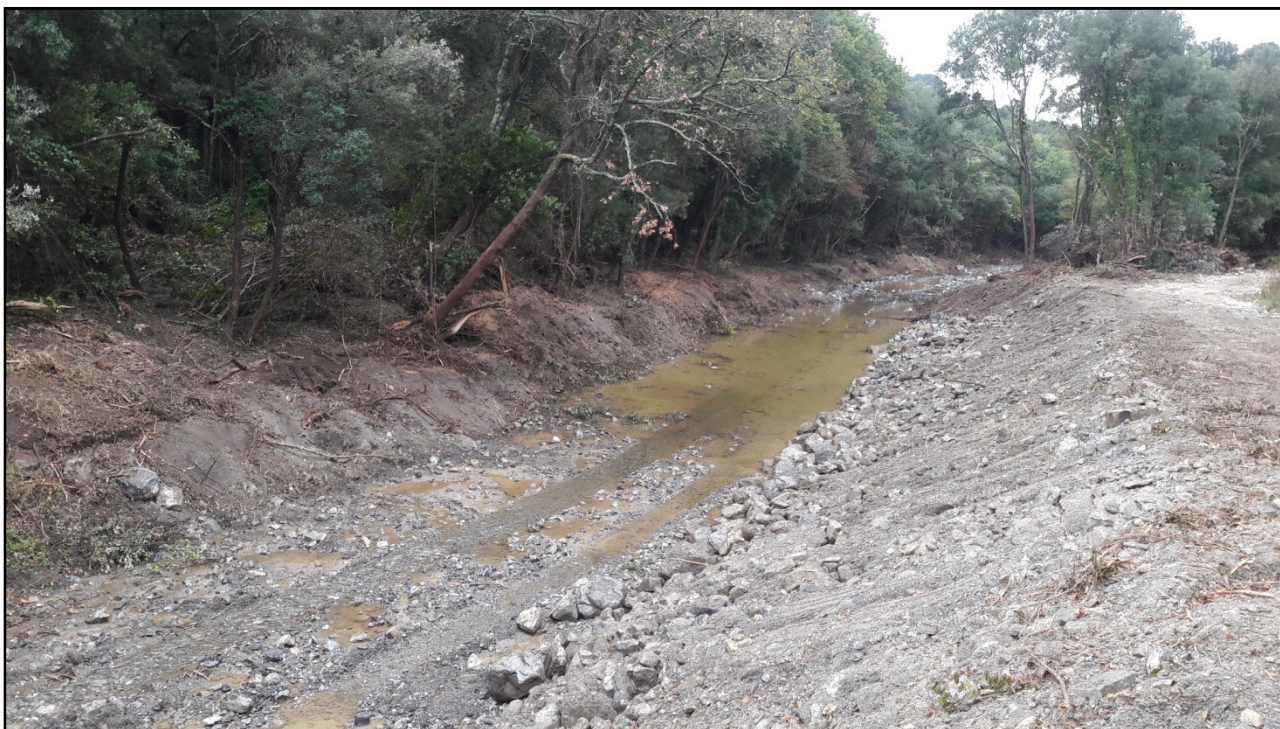
FOTO45.INTERVENTO 7 – AREA DI REALIZZAZIONE DELLA SCOGLIERA - VISTA DA MONTE
