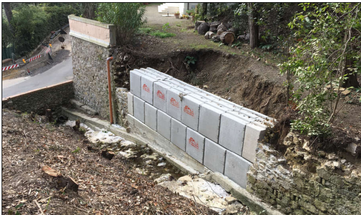
FIGURA 2. TRATTO CON MURO PROVVISORIO IN GEBLOCCHI
