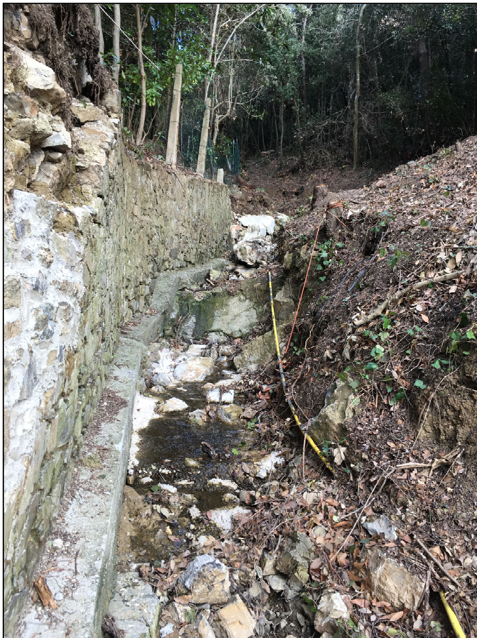
FOTO 2. VISTA DA VALLE DELLA PARTE INIZIALE DELL'AREA OGGETTO DEI LAVORI
