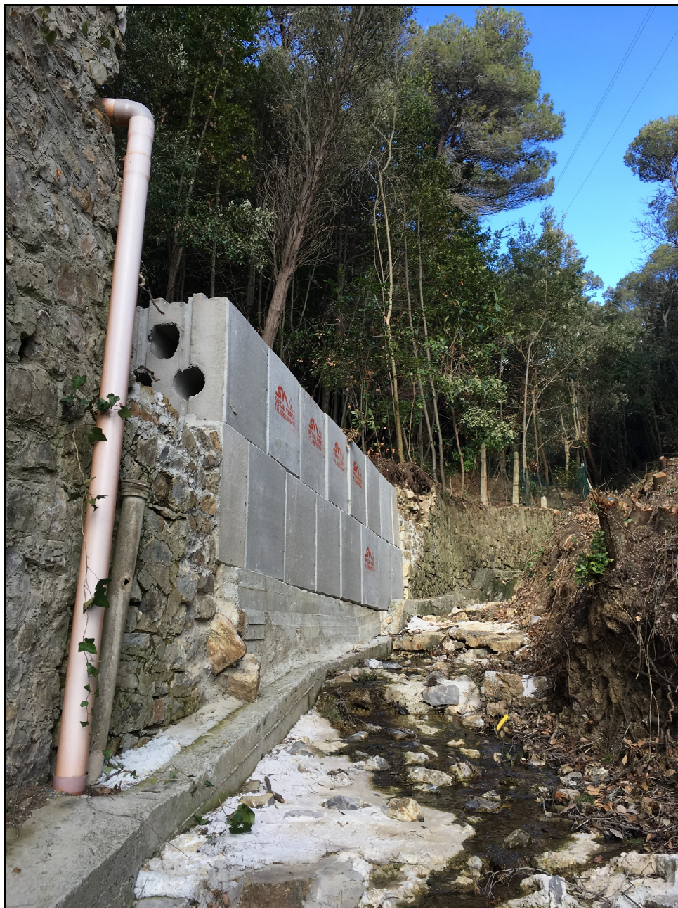
FOTO 4. VISTA DA VALLE DEL MURO IN GEOBLOCCHI REALIZZATO IN SOMMA URGENZA
