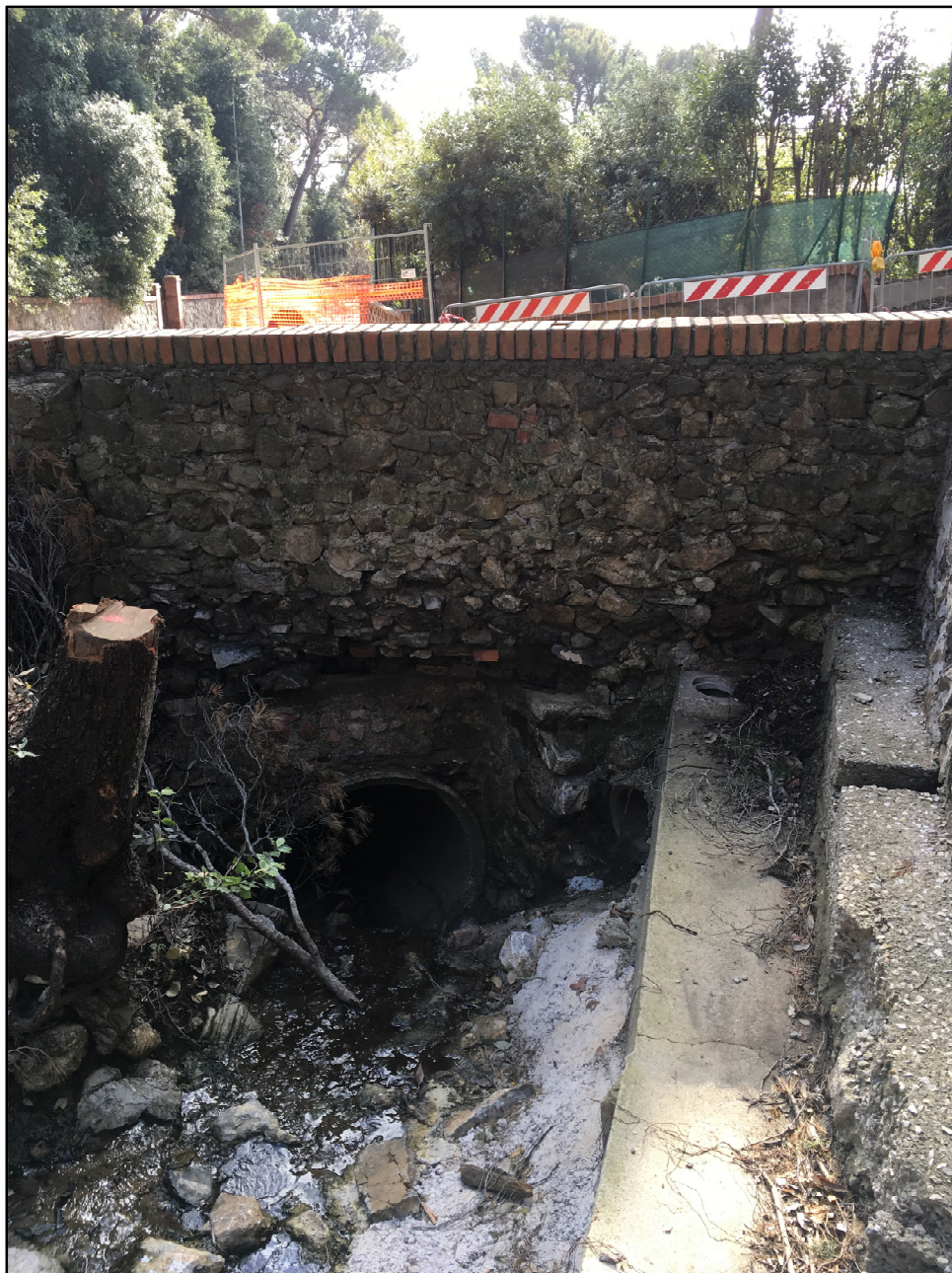
FOTO 3. VISTA DA MONTE DEL TOMBAMENTO DEL FOSSO CAPRAMORTA AL DI SOTTO DI VIA KAISER PARODI
