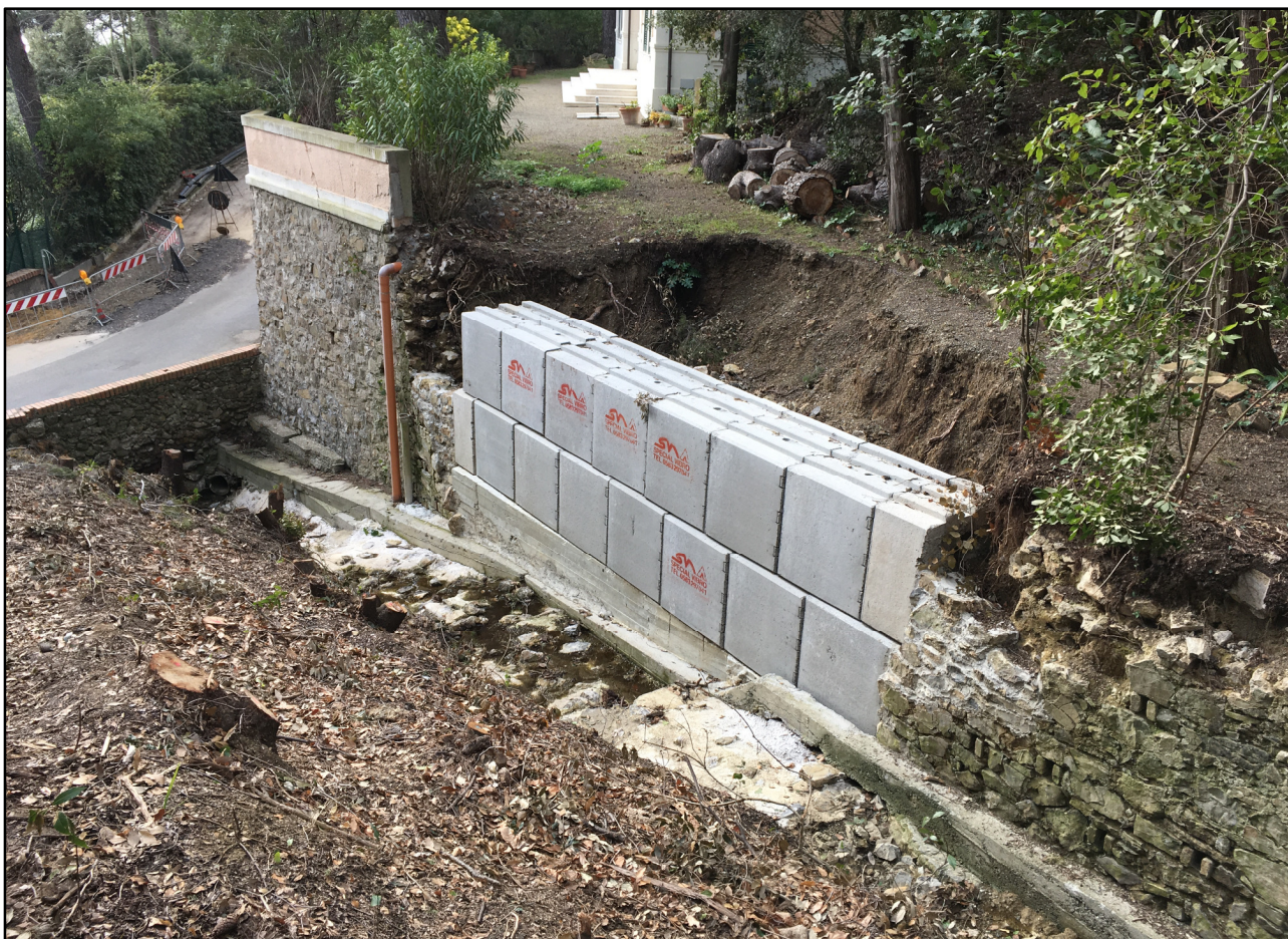
FOTO 5. VISTA DALLA SPONDA SINISTRA DEL MURO IN GEBLOCCHI REALIZZATO IN SOMMA URGENZA
