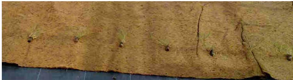
Figura 4. Deposizione delle piante preradicate a distanza prefissata.
