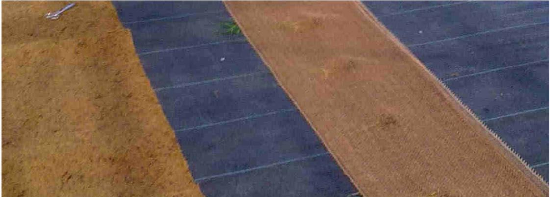
Figura 3. Telo di cocco (a sinistra) e telo di juta (a destra)
