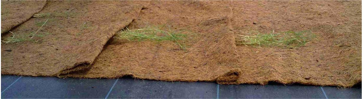
Figura 6. Materiale di supporto a copertura del pane di torba: dettaglio del sistema a pieghe adottato per il telo di cocco
