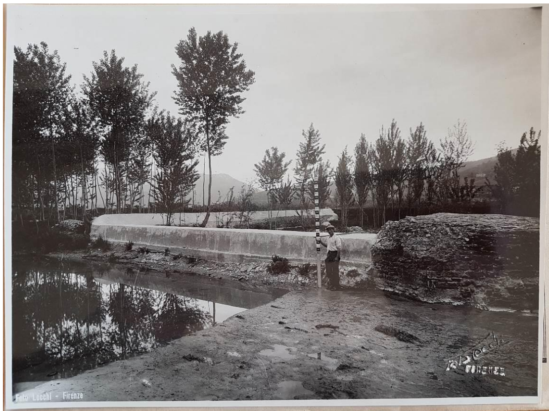
FIGURA 5: FOTOGRAFIE DEI LAVORI DI RICOSTRUZIONE DELL'ARGINE DELLA BRIGLIA CONSERVATA PRESSO GLI UFFICI DEL GENIO CIVILE DI FIRENZE DATATA 1937 . EVIDENTE IN PRIMO PIANO IL TORO IN PIETRA IN SPONDA SINISTRA ANCORA PRESENTE
