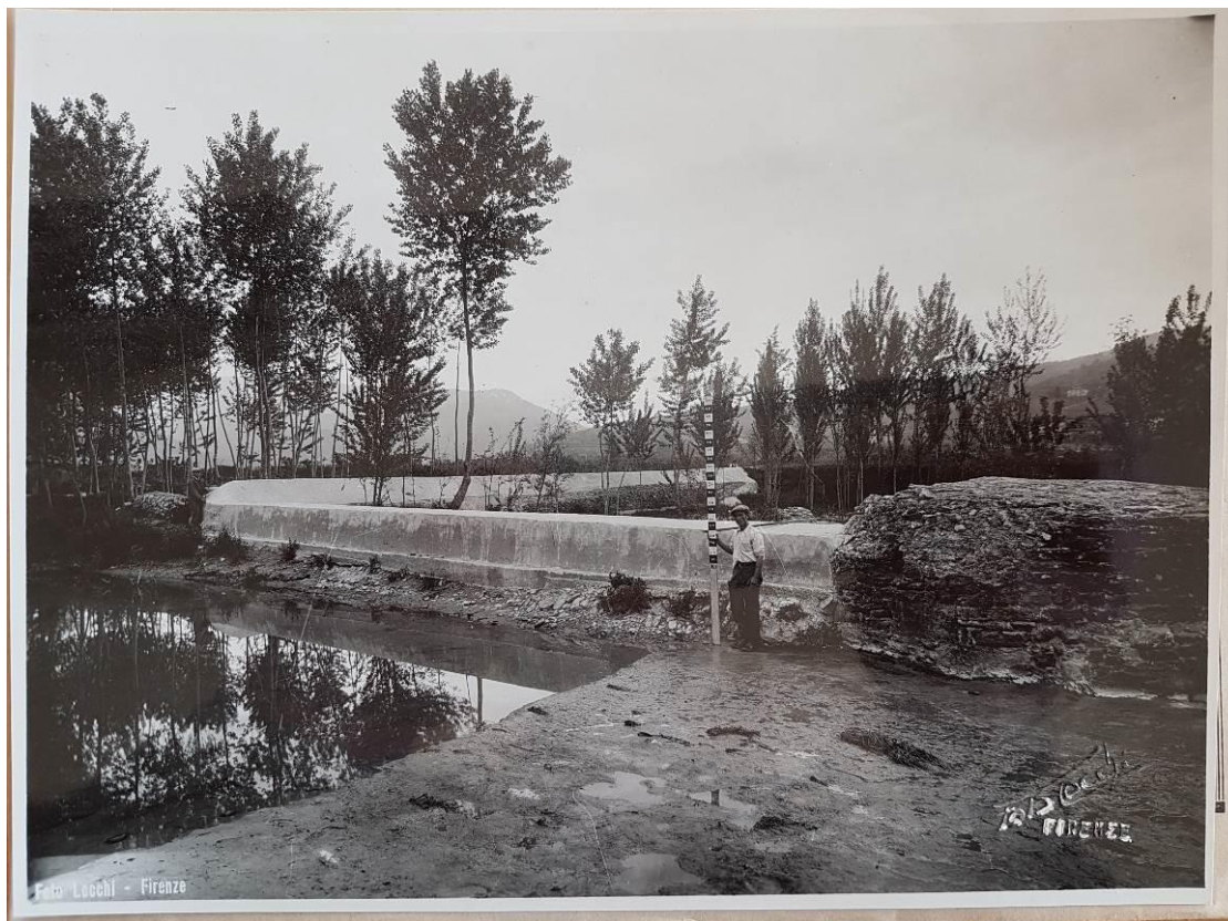
FIGURA 2-6: FOTOGRAFIE DEI LAVORI DI RICOSTRUZIONE DELL'ARGINE DELLA BRIGLIA CONSERVATA PRESSO GLI UFFICI DEL GENIO CIVILE DI FIRENZE DATATA 1937 . EVIDENTE IN PRIMO PIANO IL TORO IN PIETRA IN SPONDA SINISTRA ANCORA PRESENTE
