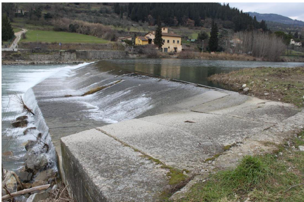
Vista della spalla in C.A. della briglia su lato sinistro, ove verrà inserito il corpo del locale macchina.
