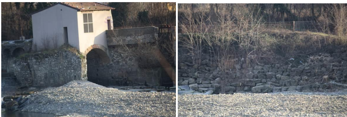
FIGURA 14: particolare dello scarico di gora della pescaia di Sieci e della muratura in pietra locale presente
