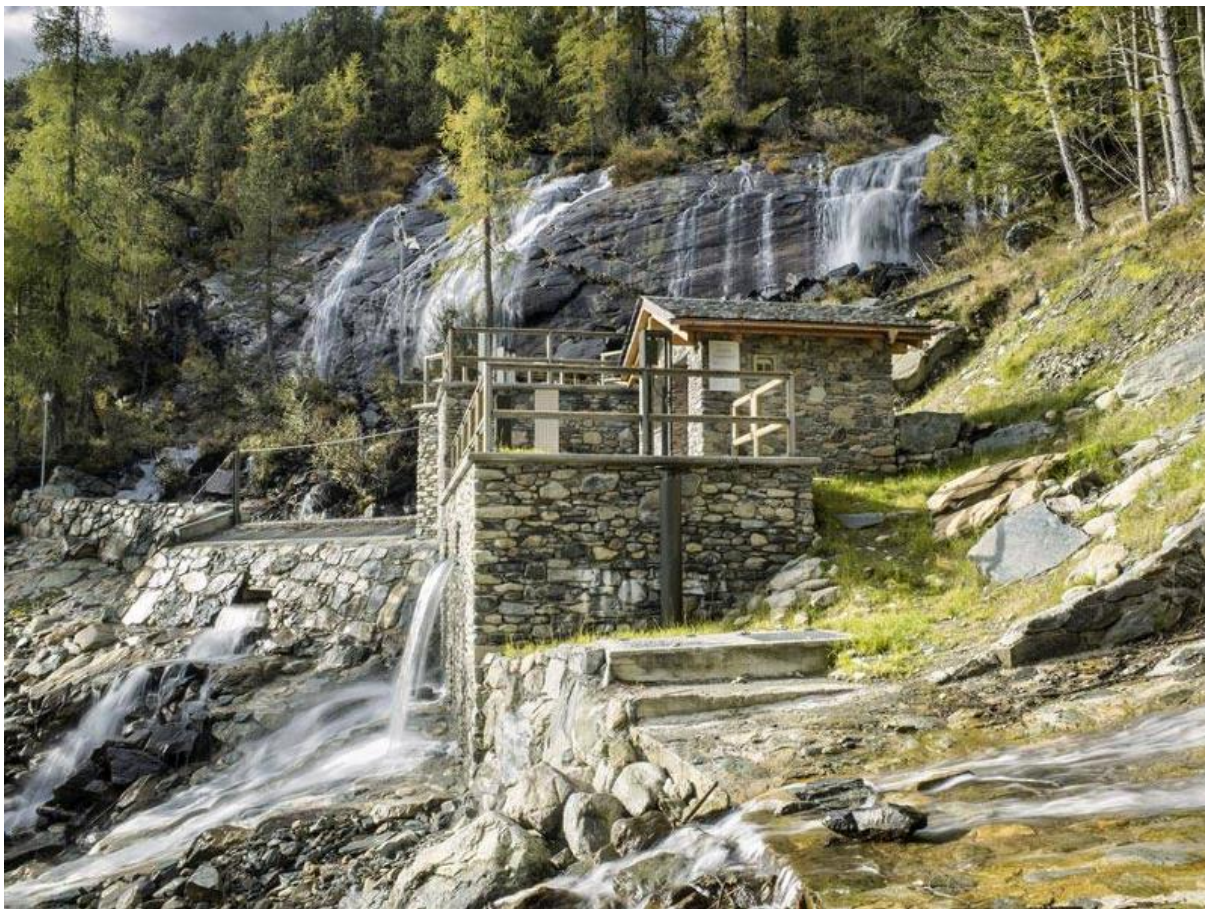
FIGURA 23: Opera di presa ai piedi della cascata dell'alpe Pirlo dell'impianto lungo il fiume Secchione (Sn), 2014 Similare per caratteristiche di integrazione al territorio circostante la sottostante centrale idroelettrica, sempre in provincia di Sondrio.
