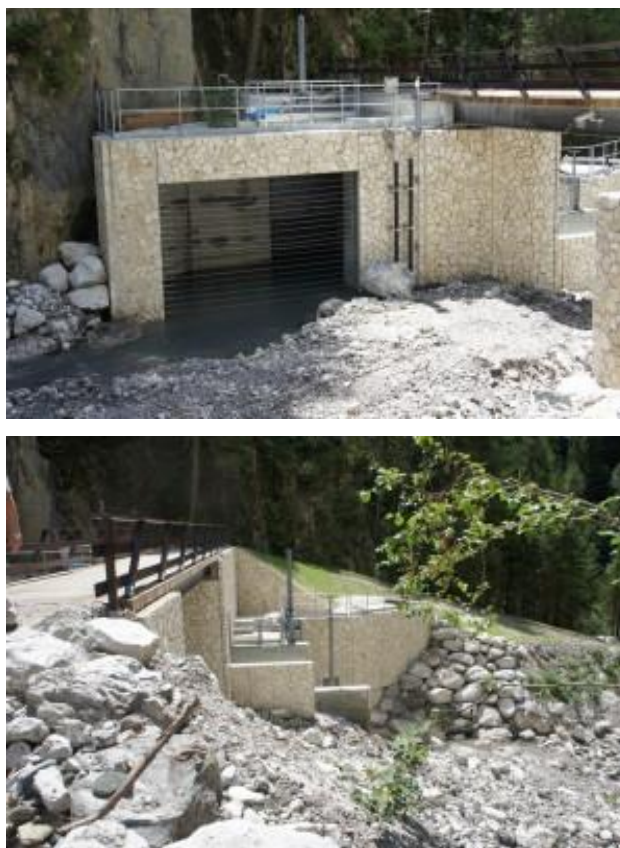
FIGURA 29: Impianto mini hydro Vallesina, centrale idroelettrica ad acqua fluente sul torrente Vallesina nel comune di Valle di Cadore (BL), costruita da En&En, 2012- 2013.
