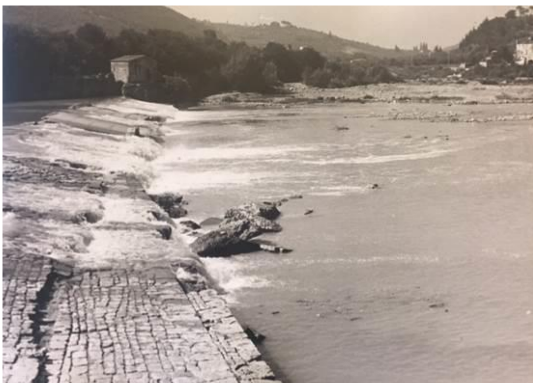
FIGURA 13: cartolina illustrata in b/n tratta dalla Collezione Carlo Benvenuti che ritrae la pescaia di Sieci intorno agli anni '50 del XX secolo. Da notare la presenza del dorso della briglia ancora intatto costituito da blocchi di pietra locale disposti in filari regolari, a differenza degli attuali blocchi di cemento e pietra sulla parte bassa della briglia, ben evidenti nell'immagine attuale della pescaia.
