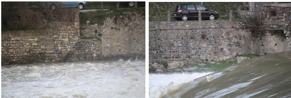
FIGURA 38: Particolari del muro in destra idraulica del fiume Sieve alla pescaia di San Francesco, realizzato in bozze squadrate di pietra locale
