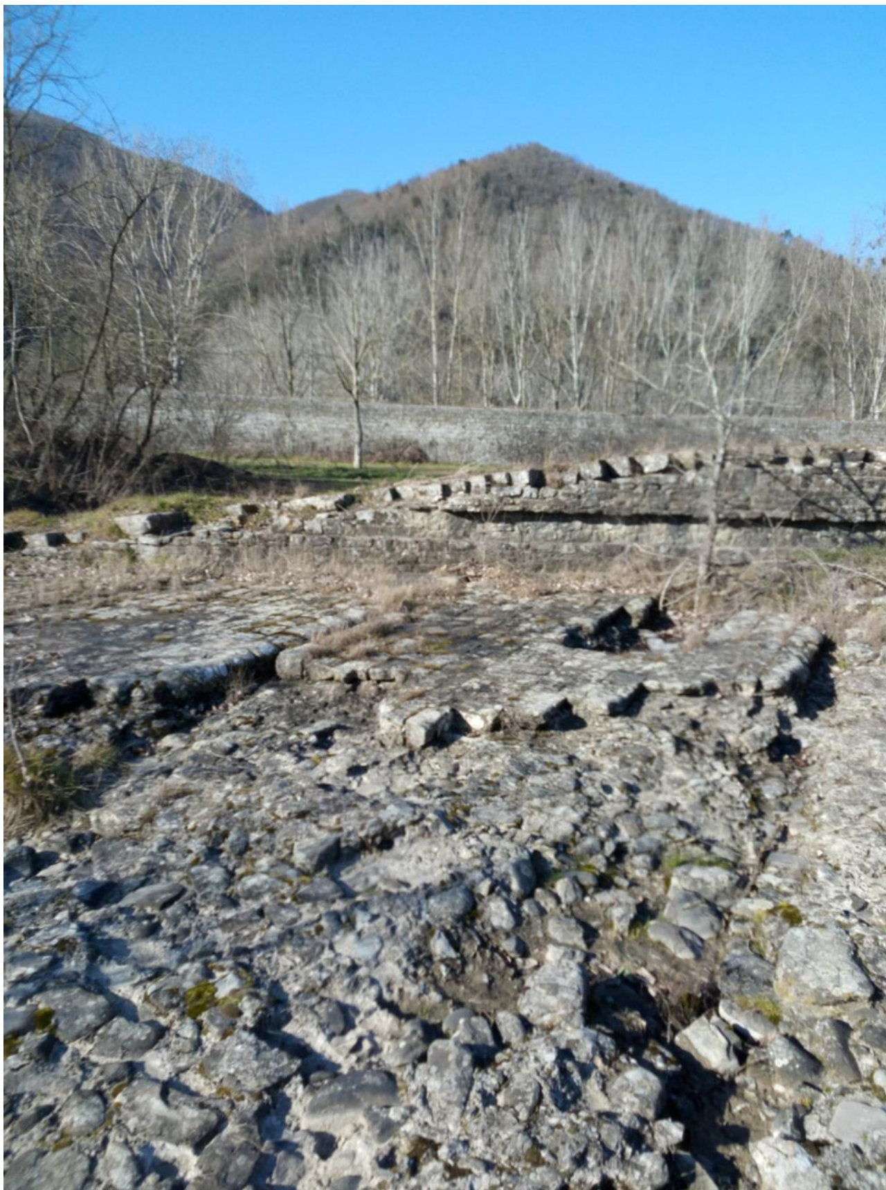
FIGURA 2-7: VISTA DA VALLE – DESTRA IDRAULICA. SEZIONE DELLA BRIGLIA ESISTENTE NEL PUNTO DI ROTTURA DELLA STESSA. IN LONTANANZA OPERA DI CONTENIMENTO IN MURATURA
