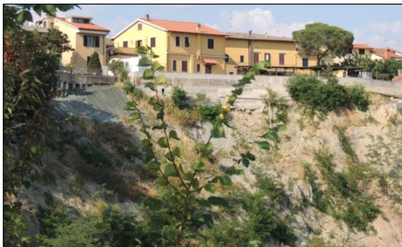
*Fig.25 - Opere di consolidamento realizzate sul lato sud degli edifici di piazza Unità d'Italia, Montespertoli: paratie di pali con cordolo di testa scalzati alla sommità da processi di erosione e dilavamento lungo la scarpata principale di frana 14.*
