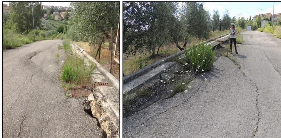
Fig.15 - Frana 6, Montespertoli (vedi Fig.22). Ondulazioni e fratture lungo la strada secondaria nei pressi della Strada Provinciale Volterrana.
