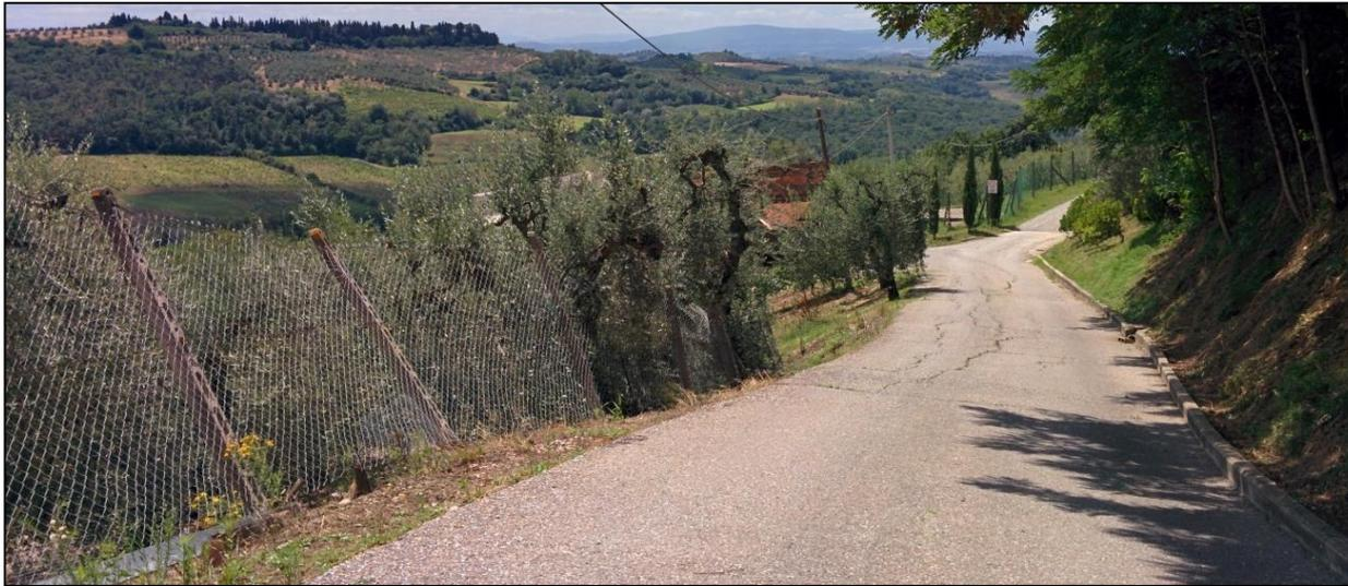
*Fig.27 - Particolare di via San Ripoli, Montespertoli: crepe e deformazioni del manto stradale e piegamento di una recinzione, legati all'arretramento della scarpata principale di frana 14.*
