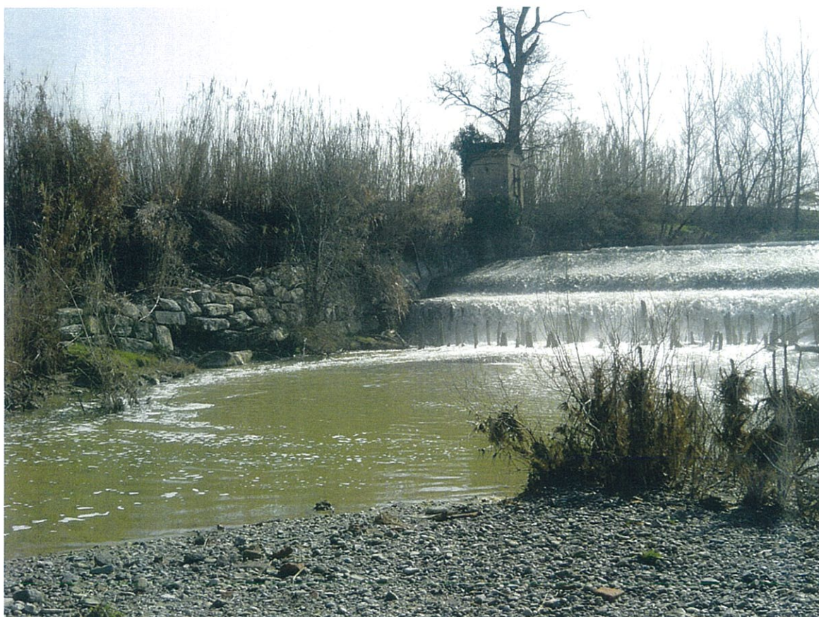
Figura 17 – Vista della scogliera (cadente) in sponda destra sotto briglia
