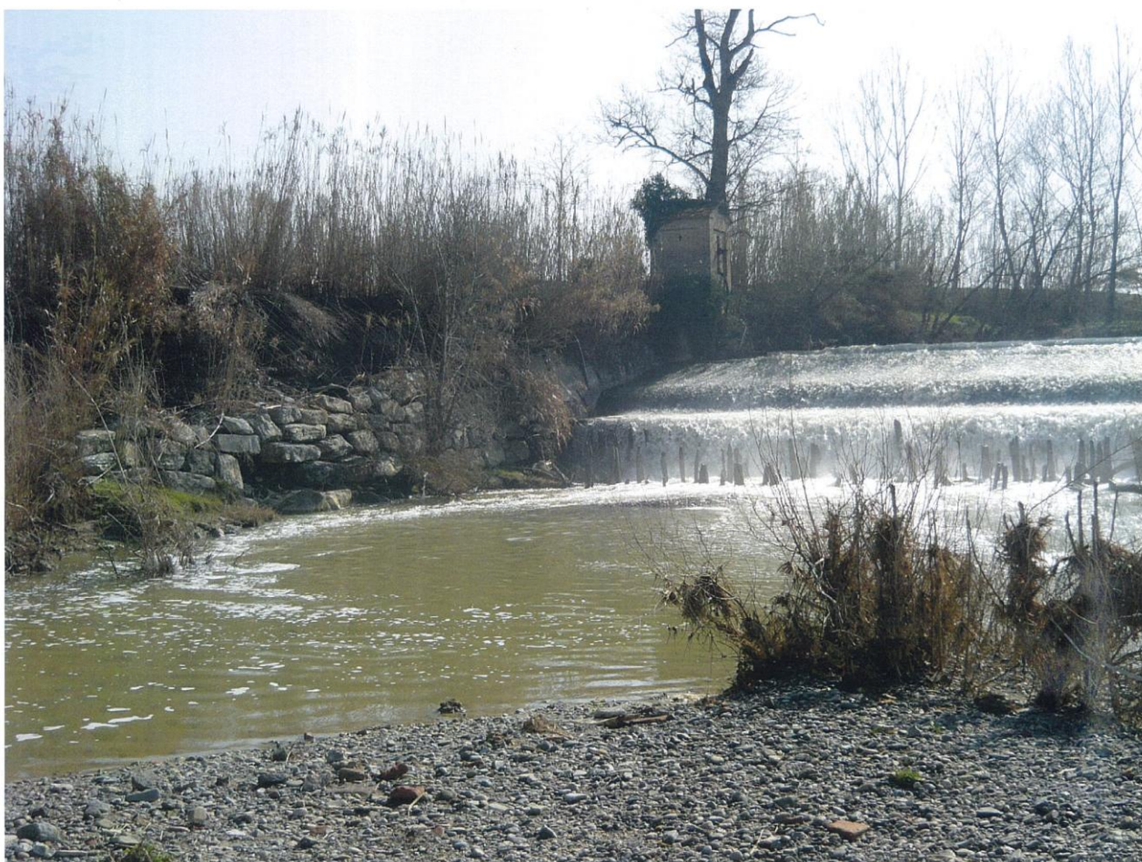
Fig.17 – Vista della scogliera (cadente) in sponda destra sotto briglia
