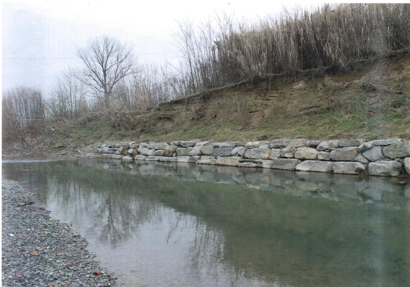
Fig.6 – Vista dell'erosione di sponda
