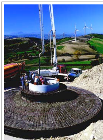
Fig. 11 - Fondazione in realizzazione
