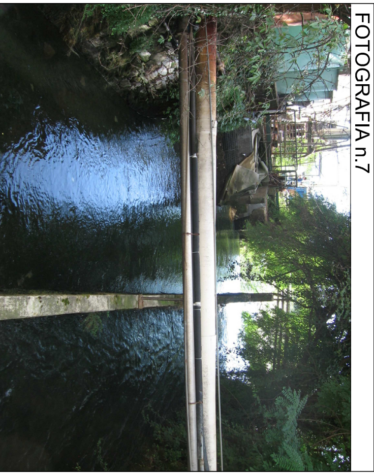
In primo piano il canale di derivazione in discesa, sul fondo le griglie inclinate dell'opera di captazione esistente, vista da monte.
