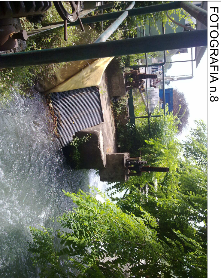
Griglia inclinata di captazione dell'impianto esistente, vista da monte.
