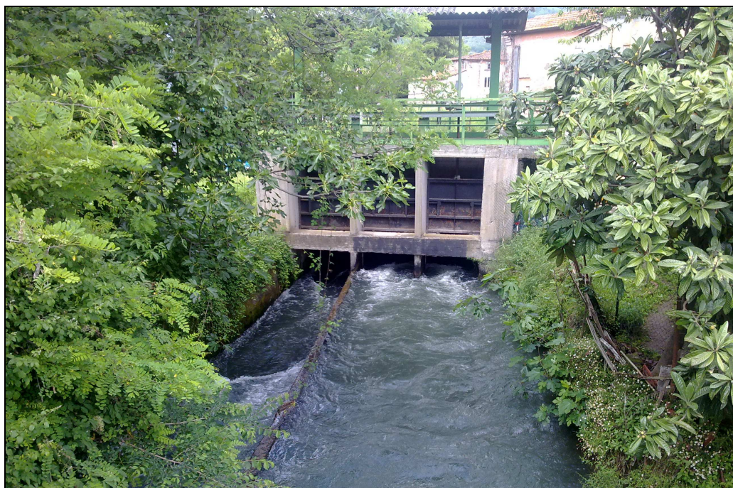
Figura 1: Sistema di tre paratie poste dove il canale di derivazione viene in luce, vista da valle verso monte.
