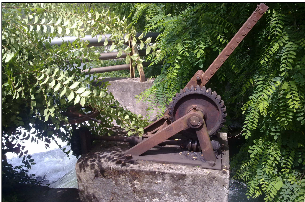
Figura 5: Organo di regolazione della paratia, oggi in disuso, subito a monte dello sfocio nel fiume Serchio delle acque non turbinate.
