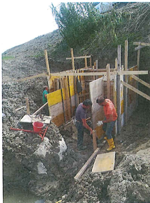
Foto 4 – Fasi di lavorazione: preparazione carpenteria muri di spalla e tetto frontale
