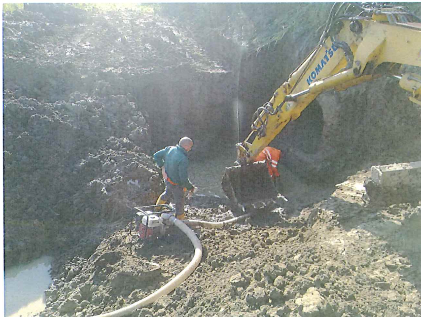
Foto 2 – Fasi di lavorazione: rimozione del materiale collassato in corrispondenza dello sbocco del manufatto
