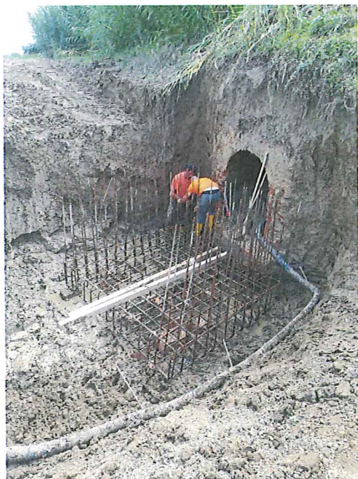
Foto 3 – Fasi di lavorazione: armatura e getto platea di fondazione
