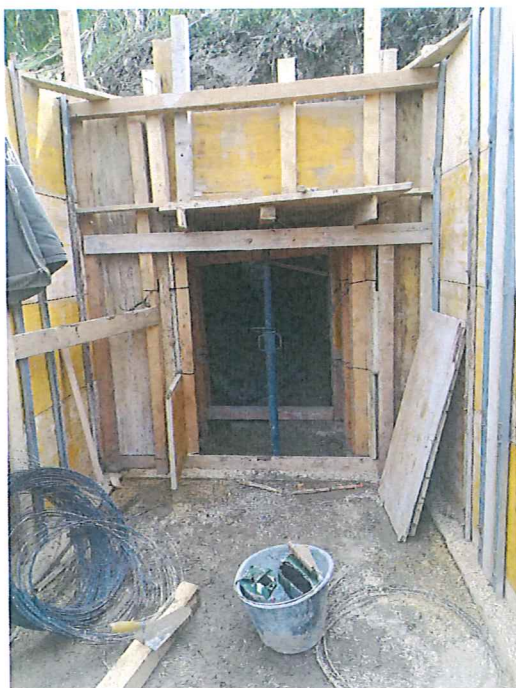
Foto 4 – Fasi di lavorazione: preparazione carpenteria muri di spalla e tetto frontale
