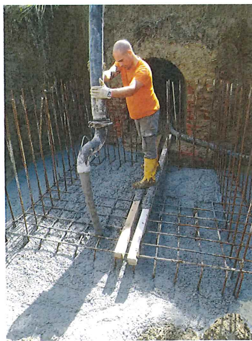
Foto 3 – Fasi di lavorazione: armatura e getto platea di fondazione
