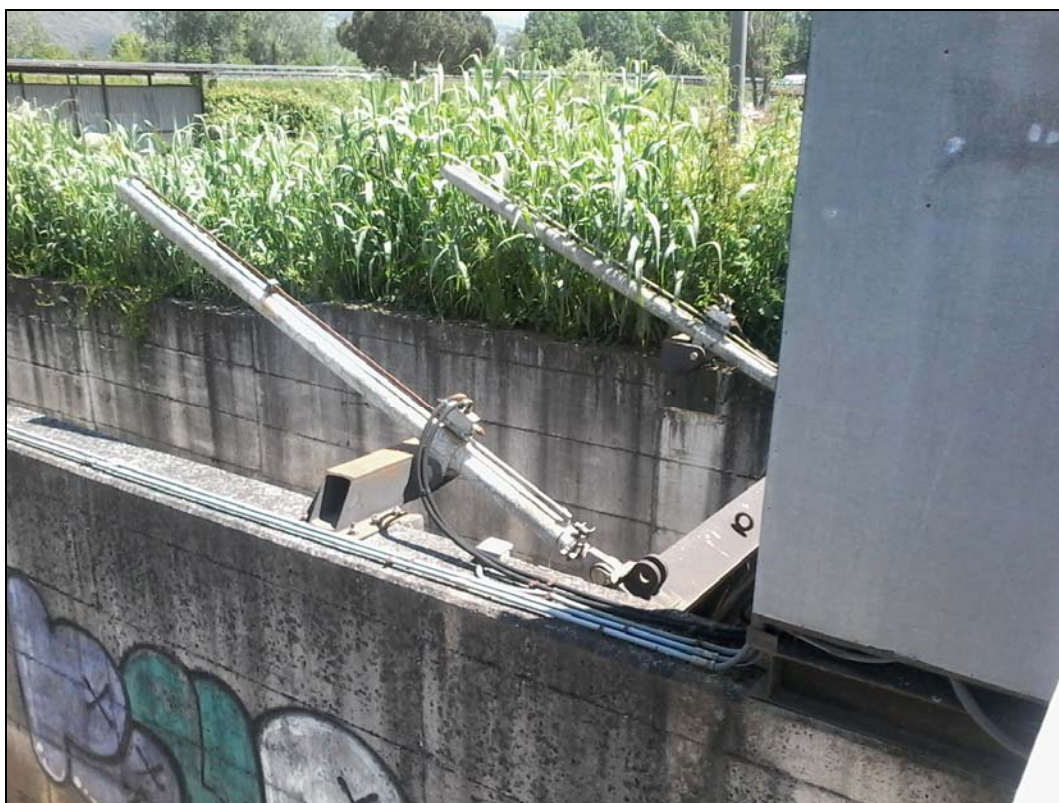
Figura A-30 – Particolare dei due pistoni idraulici che regolano l'apertura della paratoia oleodinamica.
