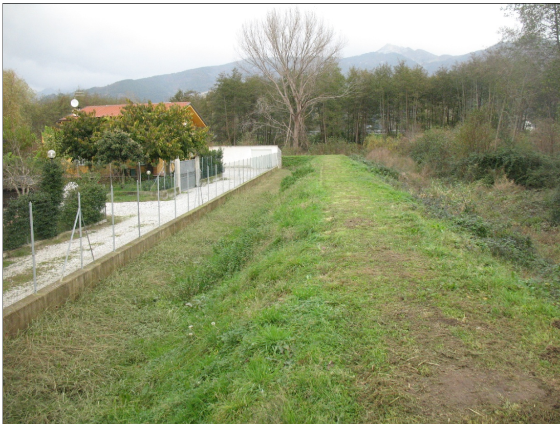
Figura 12-3 – Arginatura lato Ovest della cassa d'espansione.
