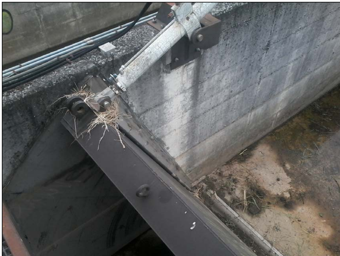
Figura 3-5 – Particolare sistema di apertura della paratoia oleodinamica.
