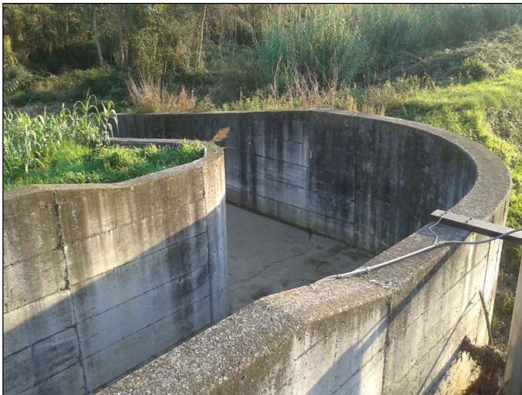
Figura A-29 – Canale di alimentazione della cassa (Foto 29).
