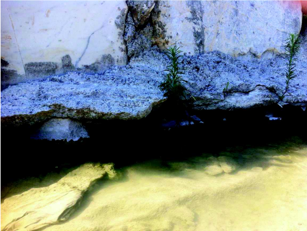
Fig. 3 Scalzamento della scogliera
