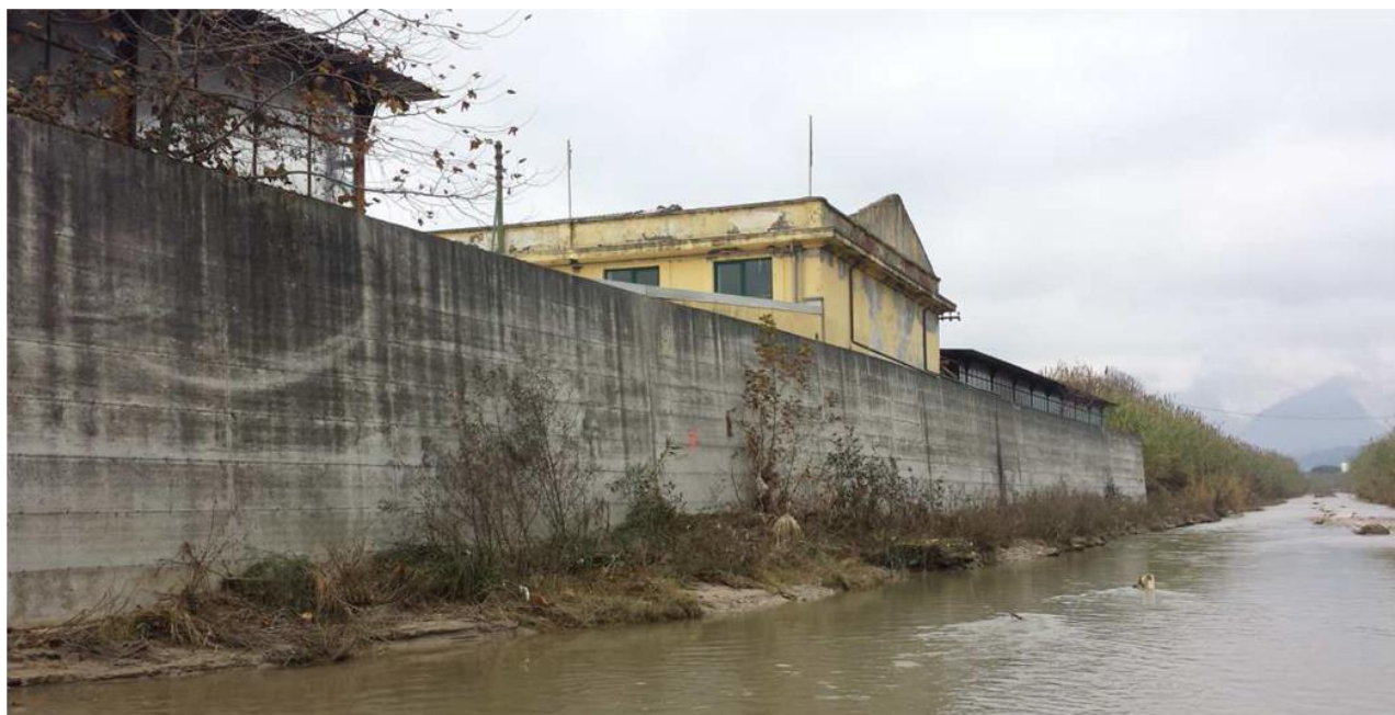
Fig. 9 – Foto Muro arginale in c.a.
