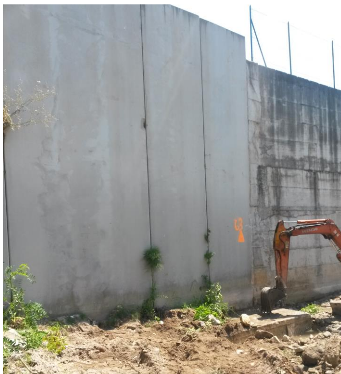
Fig. 19 – Foto Muro lato alveo – particolare giunti
