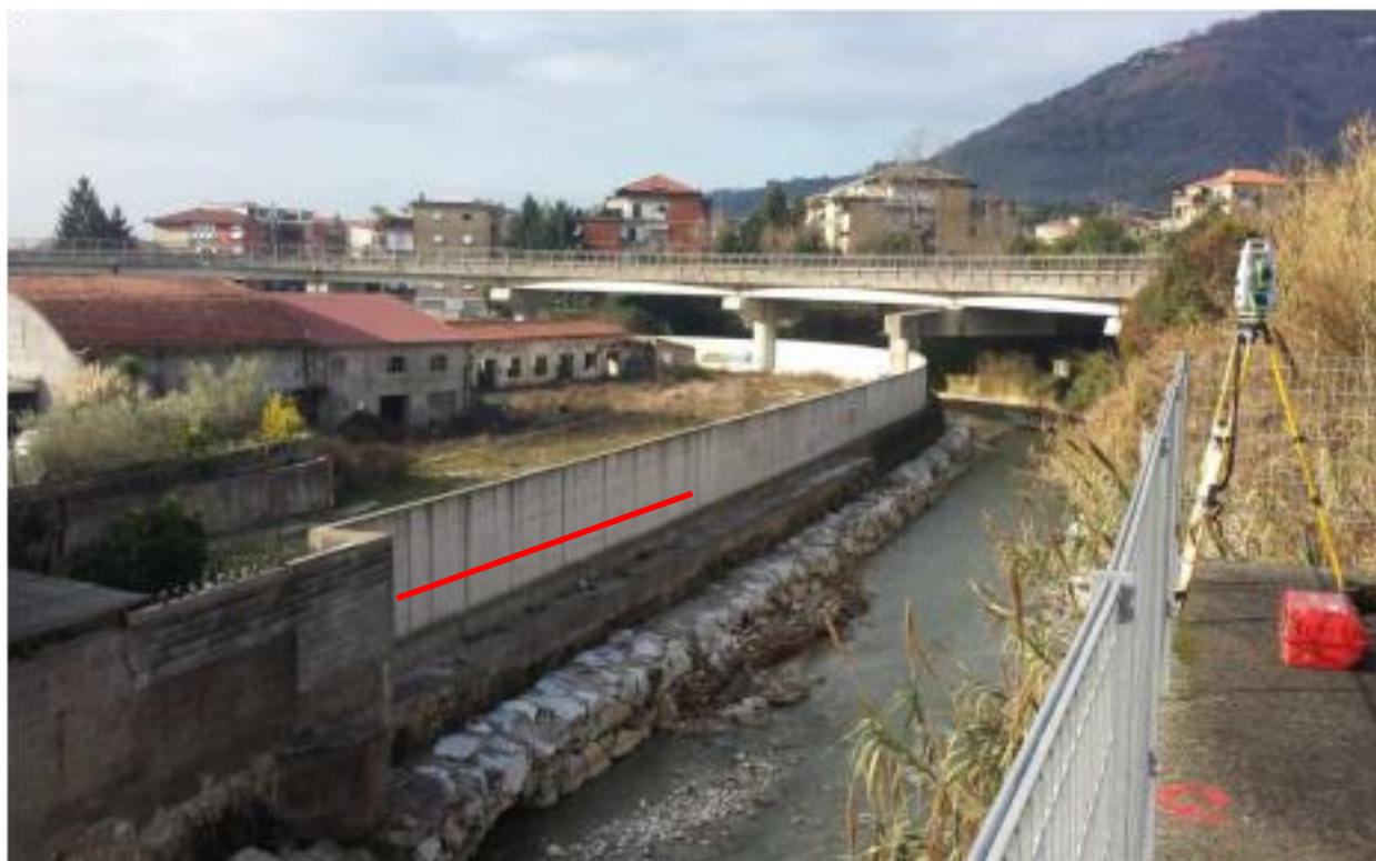
Fig. 20 – Foto Muro arginale in c.a.
