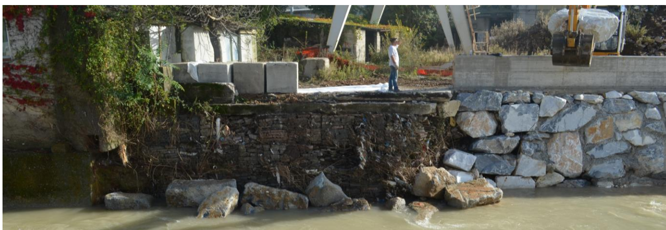
Fig. 11 – Foto Muro arginale tipo berlinese – lavori in corso (chiusura dei varchi aperti con geoblocchi)
