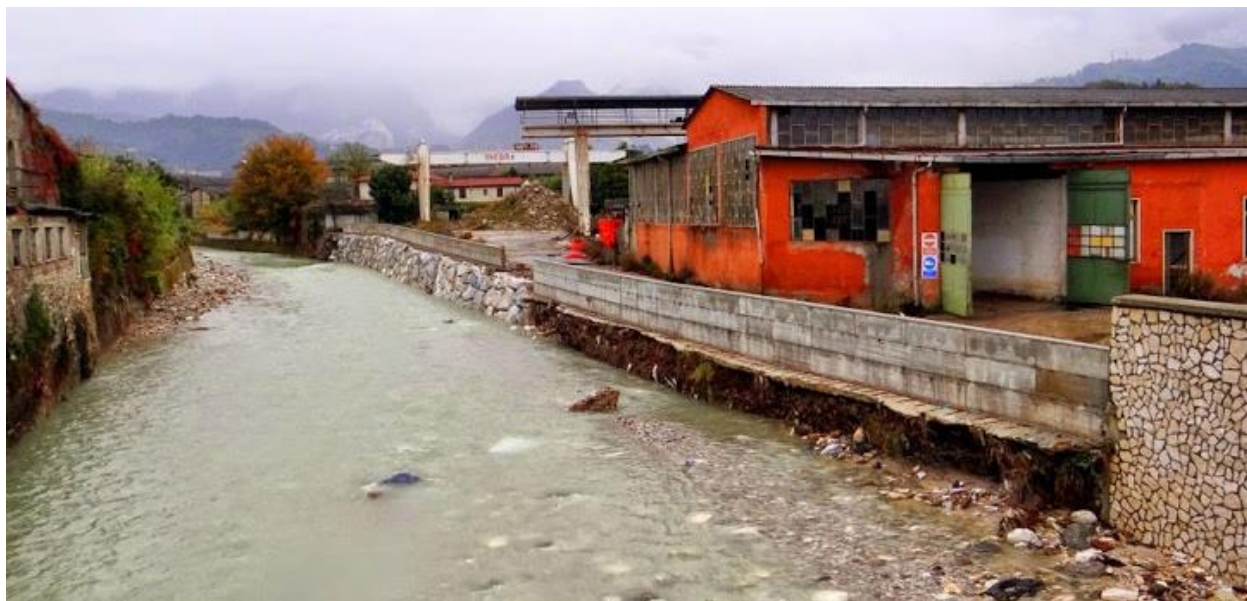
Fig. 12 – Foto Muro arginale tipo berlinese – lavori in corso (parete da richiudere)
