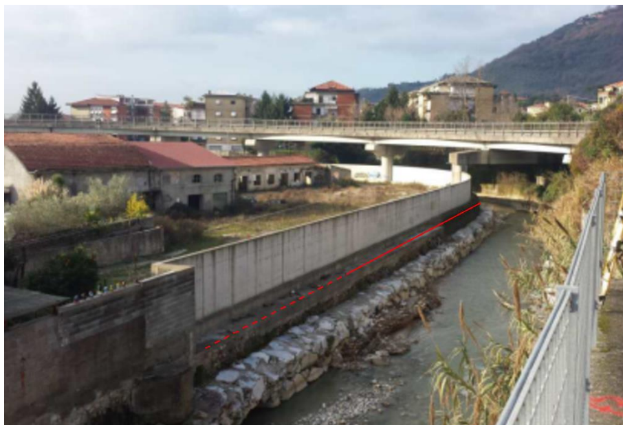
Fig. 26 – Sezione n.74 – linea tratteggiata (muro di sopralzo su fondazione di micropali) - linea continua (muro di sopralzo su muro esistente)
