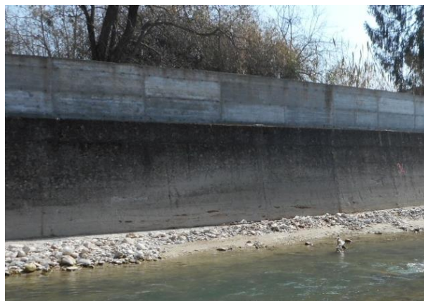
Fig. 4 – Muri a gravità in cls + sopralzo in c.a.
