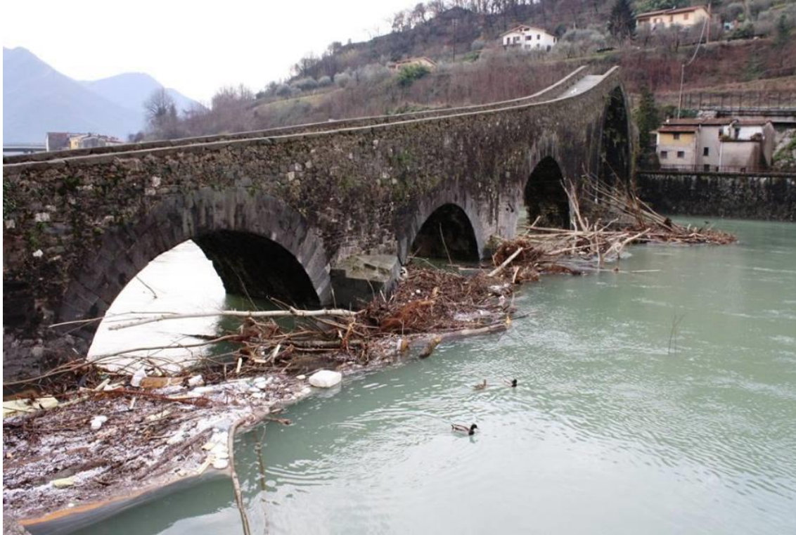
Ponte del Diavolo, Borgo a Mozzano (LU), (gennaio 2014)
