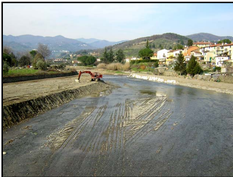
Figura 2.18 - Tratto tra la terza soglia ed il Ponte di Gello soggetto a riprofilatura (Marzo 2004).
