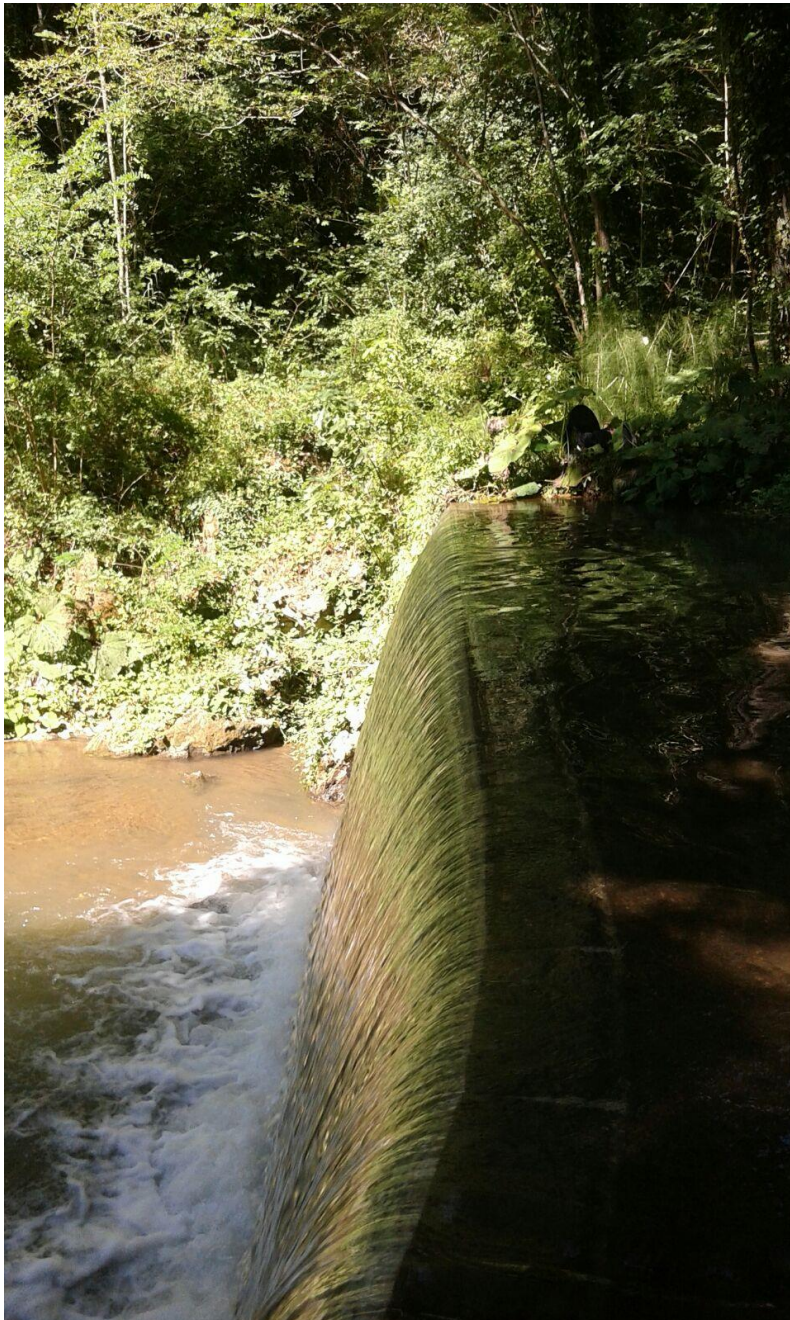
Figura 1 – Briglia esistente che si prevede di utilizzare per l’opera di presa dell’impianto idroelettrico
