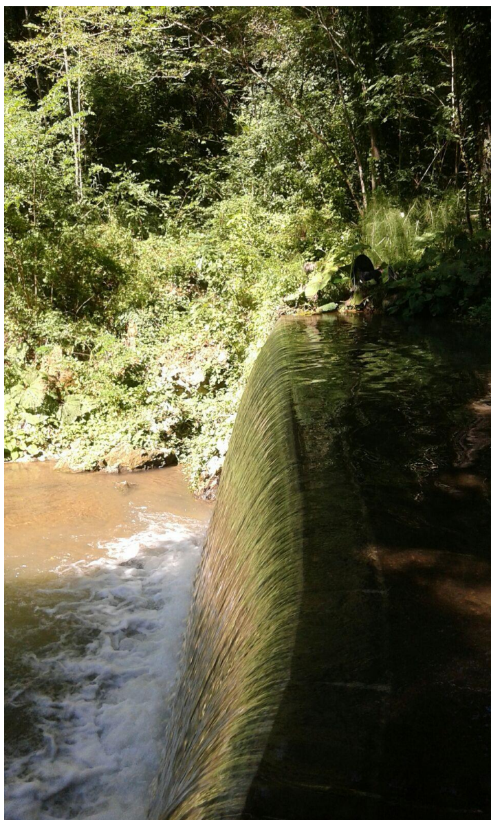
Figura 3 – Briglia esistente che si prevede di utilizzare per l'opera di presa dell'impianto idroelettrico
