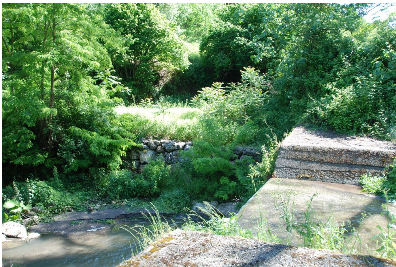
Figura 3 – Briglia esistente che si prevede di utilizzare per l'opera di presa dell'impianto idroelettrico
