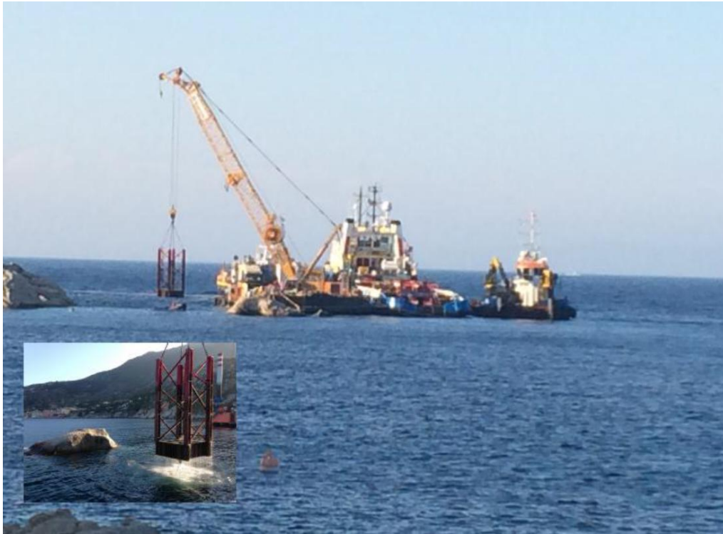
Sopra: sollevamento ultima sezione torre n.1 Sotto: banchina "Molo Galli" dopo rimozione container
