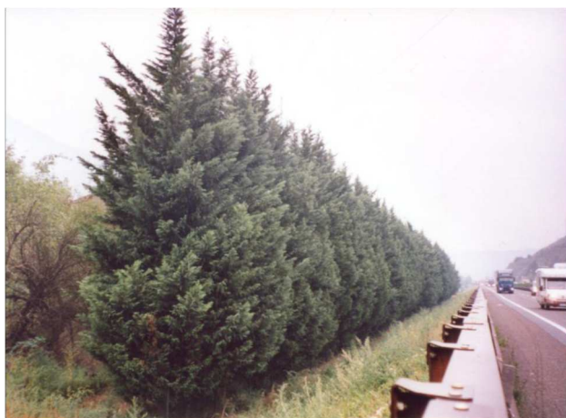
Intervento di mitigazione dell'impatto acustico lungo un'autostrada con barriere vegetali
