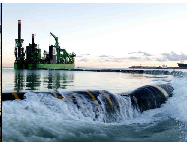
Dragaggio del porto per realizzazione colmata
