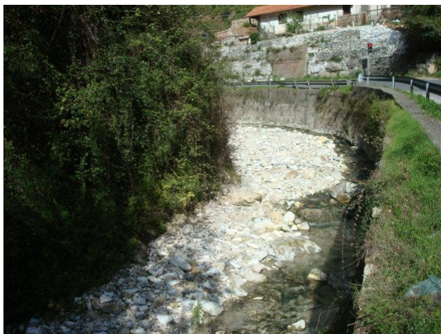
foto n 3 erosione al piede del muro strada e depositi
