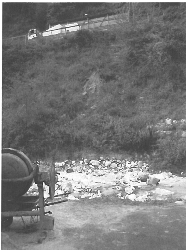
Foto n.15 Settore 6 – Erosione al piede della scarpata in destra idrografica (Sez. n.24) (Stato attuale).
