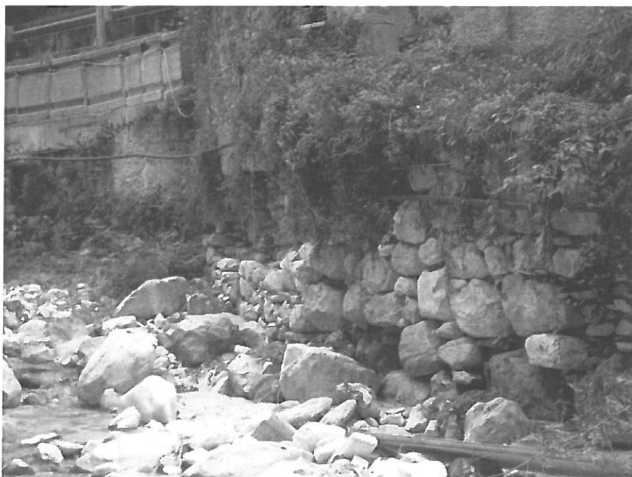
Foto n.19 Settore 6 – Sezione n. 24 bis. Scalzamento alla base del muro di sponda in pietrame posto in sinistra idrografica a valle della briglia della Sezione n. 25.
