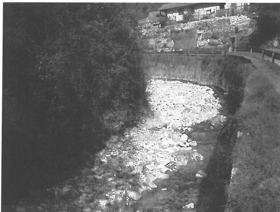
Foto n.10 Settore 3 – Sezione a monte del ponte (Sez. 13bis) (presenza di materiale alluvionale talora grossolano).
