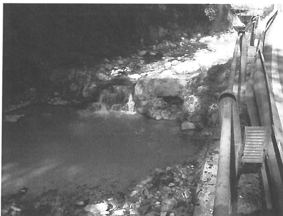
Foto n.4 Settore 3 – Briglia Sezione n.11 (segni di erosione al piede).
