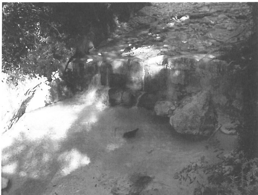
Foto n.21 Settore 6 – Sezione n.25 Scalzamento alla base della briglia.
