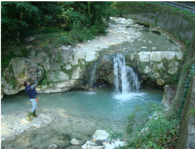
foto n 2 erosione briglie e piede muro strada
