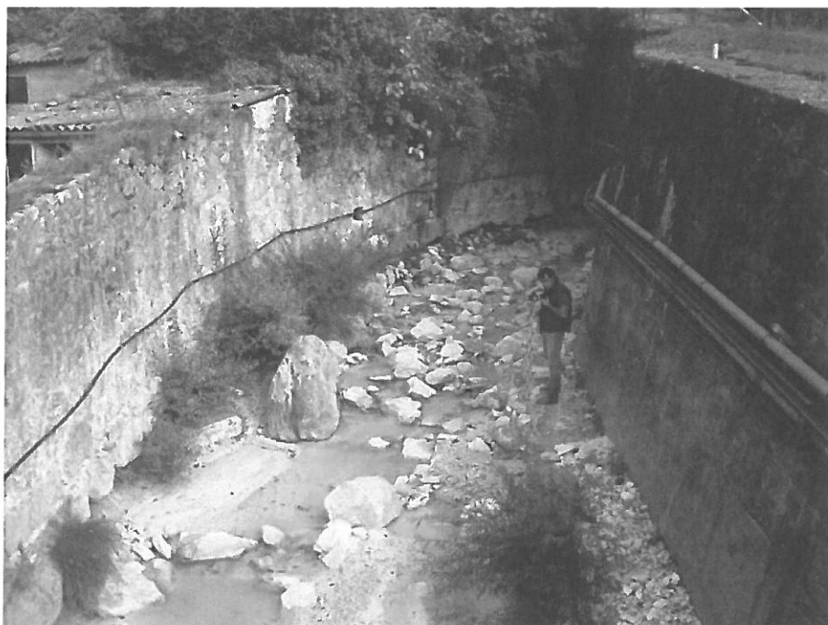
Foto n.25 Settore 7 –Scalzamento al piede del muro di sponda in pietrame che delimita, in destra idrografica, il F. di Torano.
