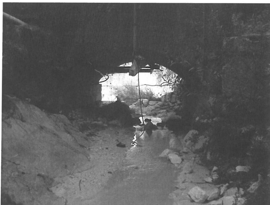
Foto n.28 Settore 7 – Sezione di monte del ponte (anche in questo caso si nota la presenza di condotte in alveo).
