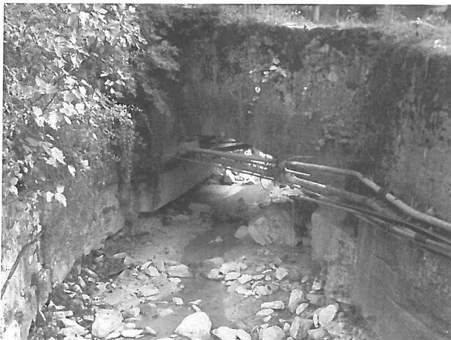
Foto n.27 Settore 7 – Sezione di valle del ponte (da notare la presenza di condotte in alveo).
