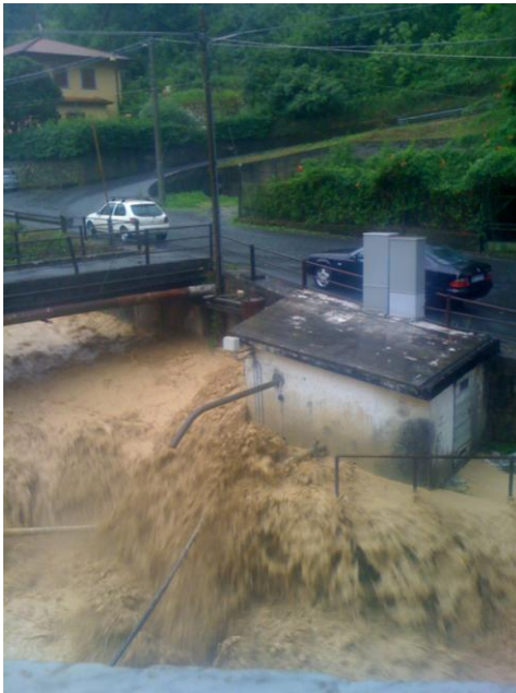
foto 15 Settore 7 costruzione in alveo che ostacola il regolare deflusso.
