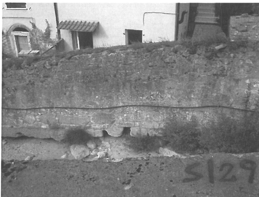
Foto n.26 Settore 7 – Particolare dello scalzamento alla base del muro di sponda in pietrame.
