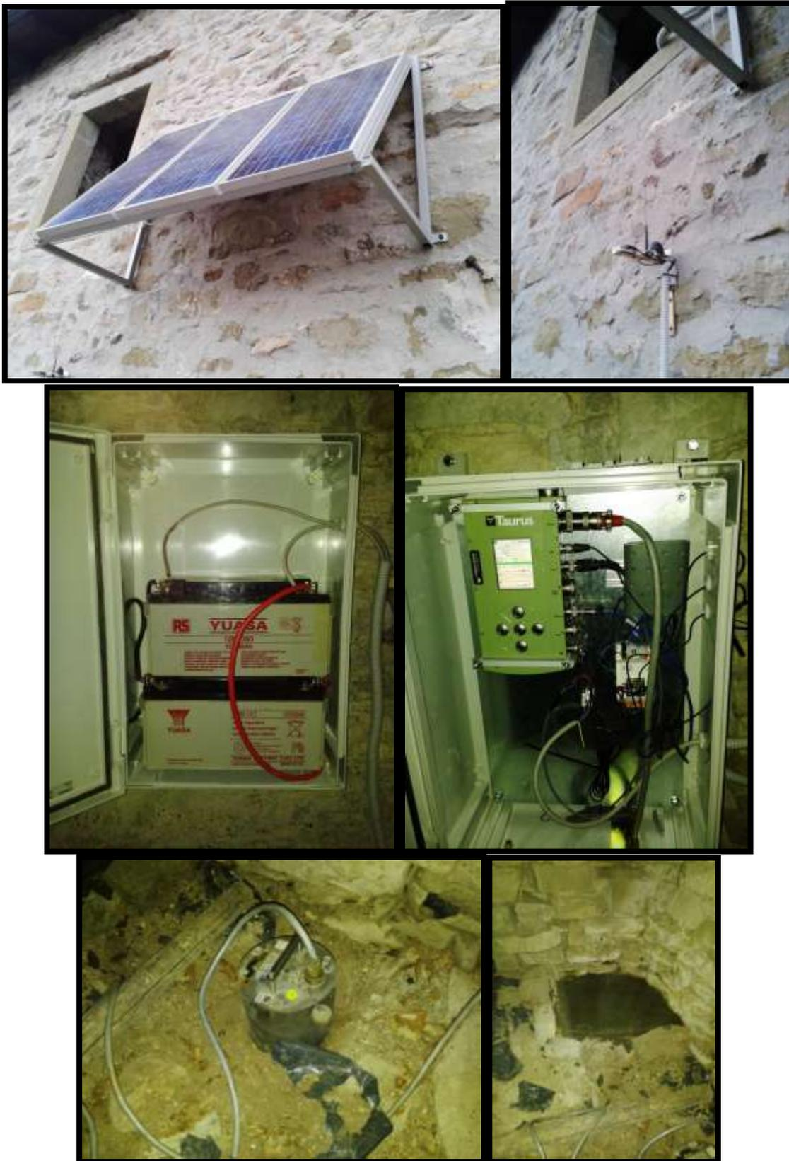
**Figura 7: Stazione GRAM – particolari relativi agli apparati installati presso il sito di Graiana: pannelli solari e antenne del GPS, del router UR5 e del Nethix (in alto); batterie tampone, acquirente taurus, router UR5 modem Nethix, centralina di regolazione per i pannelli solari (in centro); sensore sismico Guralp CMG40 e basamento in cemento (in basso)**
