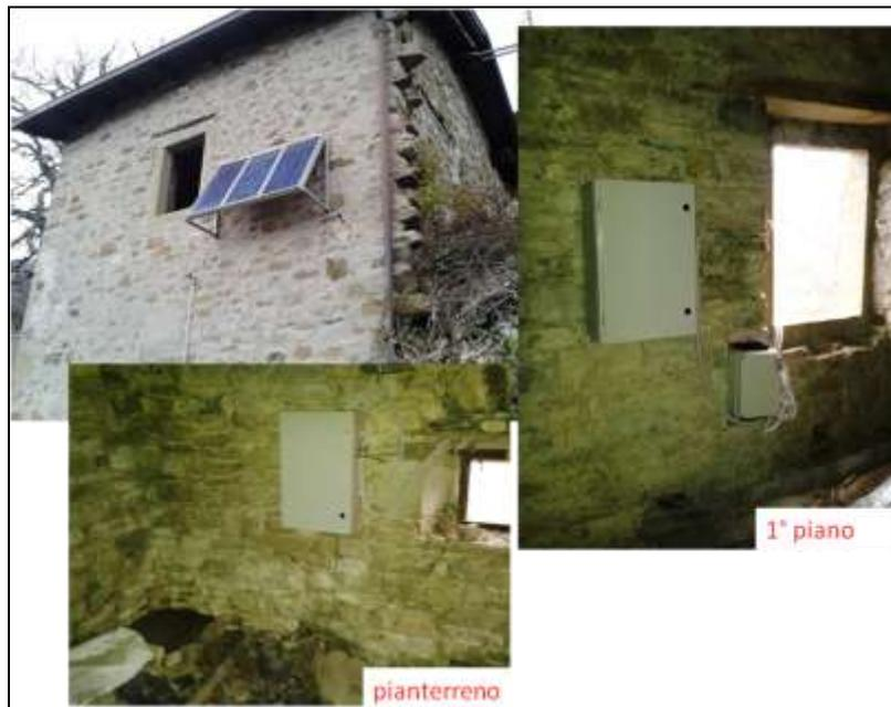
**Figura 6: Stazione GRAM – particolari relativi al sito di installazione: edificio adiacente alla chiesa di Graiana ospitante la stazione (in alto a sinistra) – armadio contenete l'acquisitore e l'apparato di trasmissione e basamento in cemento (in basso a sinistra) – armadio contenete le batterie tampone e junction box (in alto a destra)**
