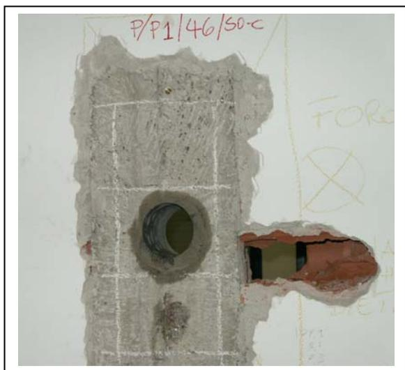
Foto 6. Foro per il passaggio dei cavi e carotaggio
