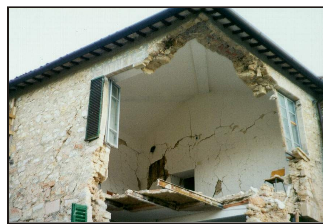
Meccanismo di danno: CROLLO DELLA PARETE L'ORIZZONTAMENTO O LA COPERTURA RIMANGONO INTATTI
