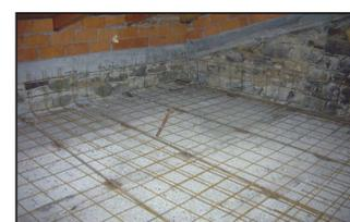
**B05.24** Irrigidimento e collegamento di solaio in ferro e laterizio mediante realizzazione di cappa in C.A.
