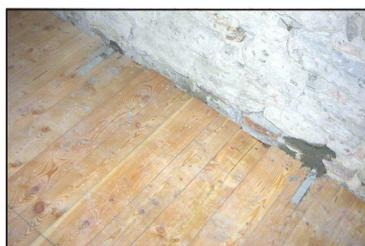
**B05.22** Irrigidimento e collegamento di solaio in legno e piano in tavolato mediante sovrapposizione di nuovo tavolato sul solaio esistente.
