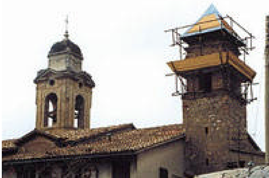
Figura 6. Cerchiatura del campanile della Chiesa S. Maria Assunta in Foligno (frazione Belfiore)
