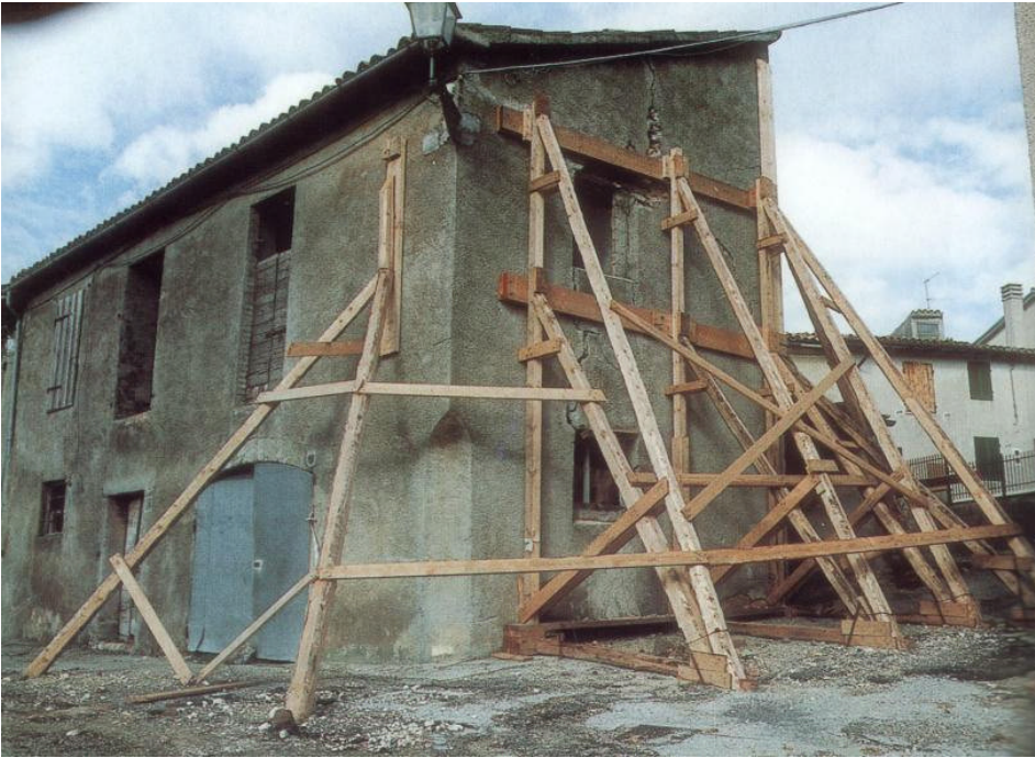
Foto 6.1. Cesi – Puntelli inclinati.
