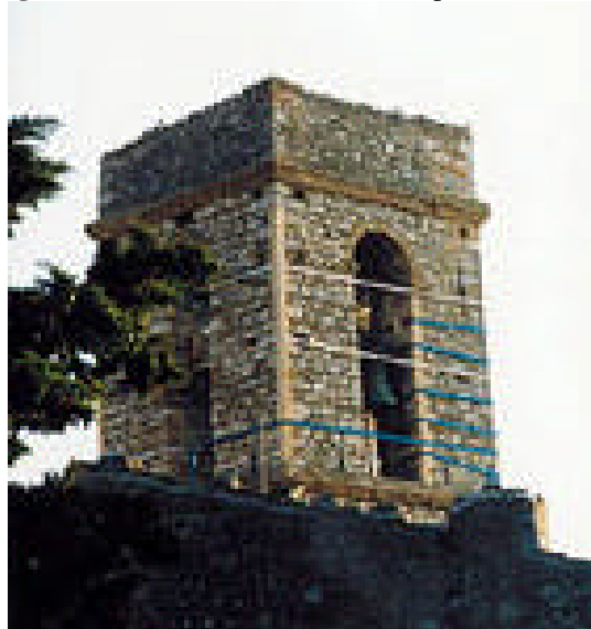
Figura 5. Cerchiatura della cella campanaria di Forfi
