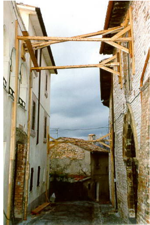
Figura 3 Cesi (Mc) –Terremoto del 26.09.97. Puntellamento di facciata e d'angolo
