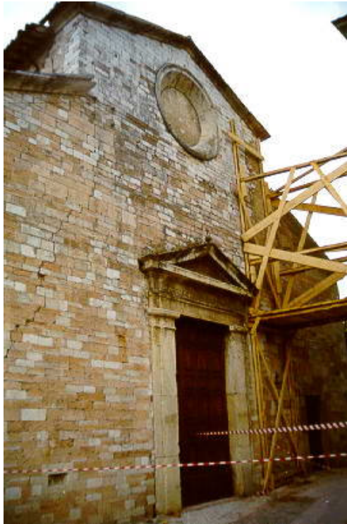
Figura 3 Cesi (Mc) –Terremoto del 26.09.97. Puntellamento di facciata e d'angolo
