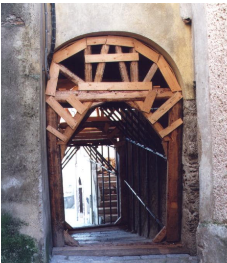
Foto 7.4 Rivello – Arco con centina.
