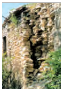
Fig. 3.2 – Ps: sezione a paramenti con elementi scollegati o male ammassati come evidenziato da crolli rovinosi provocati dal sisma
