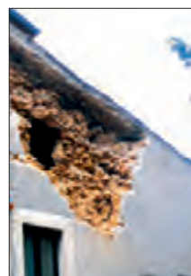
Fig. 3.1 – Pc: sezione a paramenti ben collegati o ad unico paramento (sezione piena)
