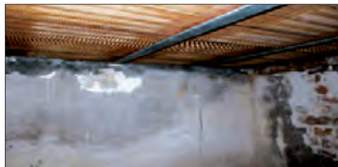
Solaio in putrelle e tavelloni
