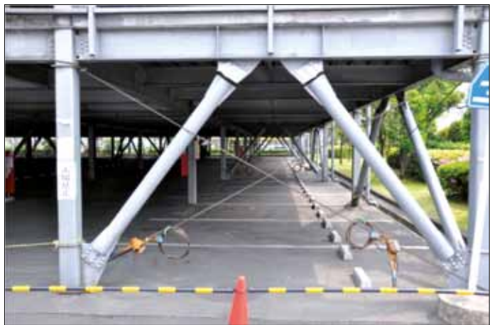
Figura 5.43: Rottura di entrambi i fazzoletti metallici in corrispondenza dell'attacco con i diagonali di controventamento di una struttura adibita a parcheggio. Livello di danno nel controvento: D4 - D5 (terremoto di Tohoku, Giappone 2011)
