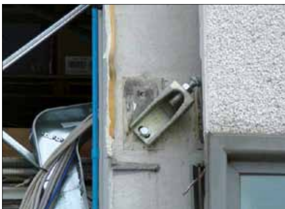
Figura 5.30: Rottura attacco mensola di supporto pannello e conseguente crollo del pannello. Livello di danno nella connessione pannello-struttura: D5 (terremoto Emilia-Romagna 2012)
