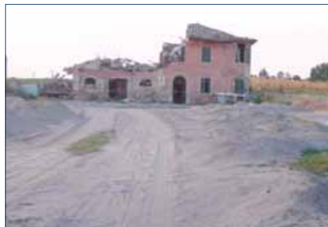
Figura 7.14: Esempi di liquefazione (terremoto Emilia-Romagna 2012)
