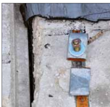
Figura 5.38: Rottura delle piastrine di ritenuta dei collegamenti tra pannello e struttura. Livello di danno: D4 - D5 (terremoto Abruzzo 2009).
