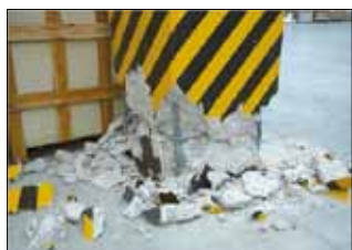
Figura 5.4: Sviluppo della cerniera plastica con espulsione di copriferro ed instabilizzazione delle barre longitudinali di armatura alla base di un pilastro di una struttura monopiano. Livello di danno nel pilastro: D4 (terremoto Emilia-Romagna 2012)
