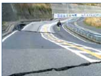
Figura 7.10: Distorsione differenziale della pavimentazione stradale in una zona residenziale di Mihama di Chiba (Giappone 2011)
