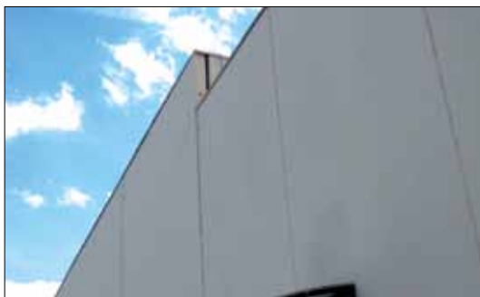
Figura 5.34: Spostamento residuo e disallineamento dei pannelli di tamponamento esterni. Livello di danno nella connessione pannello-struttura: D3 (terremoto Abruzzo 2009, Monticchio, L'Aquila)
