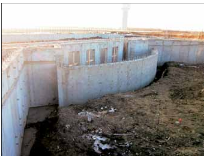
Figura 4.28. Pannelli gettati in opera.
