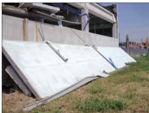
Figura 6.3: (a) Collasso di pannelli prefabbricati orizzontali in edificio monopiano. (b) Profili di acciaio nel pilastro soggetti a crisi per slabbramento (terremoto Emilia-Romagna 2012, Cavezzo (MO))
