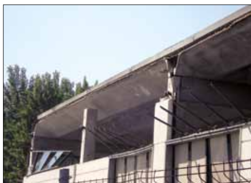
Figura 6.4: (a) Collasso di pannelli prefabbricati orizzontali in edificio monopiano. (b) Dettaglio del sistema di ancoraggio sul pilastro per l'aggancio dei pannelli orizzontali (terremoto Emilia-Romagna 2012, Mirandola (MO))
