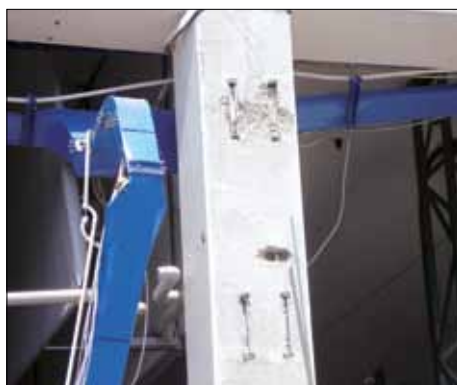
Figura 6.3: (a) Collasso di pannelli prefabbricati orizzontali in edificio monopiano. (b) Profili di acciaio nel pilastro soggetti a crisi per slabbramento (terremoto Emilia-Romagna 2012, Cavezzo (MO))
