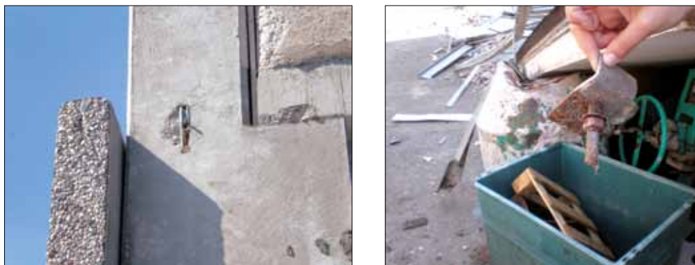
Figura 6.1: Collasso di un pannello prefabbricato orizzontale per crisi a taglio del connettore di acciaio (terremoto Emilia-Romagna 2012, Mirandola (MO))
