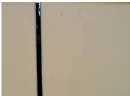
Figura 5.34: Spostamento residuo e disallineamento dei pannelli di tamponamento esterni. Livello di danno nella connessione pannello-struttura: D3 (terremoto Abruzzo 2009, Monticchio, L'Aquila)
