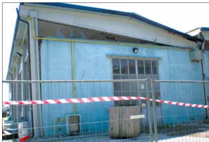
Figura 5.16: Perdita di appoggio della trave di copertura di un edificio monopiano prefabbricato a causa della crisi a taglio del pilastro di appoggio avvenuta in corrispondenza della variazione di rigidità causata dai tamponamenti non a tutta altezza. Livello di danno nella connessione trave-pilastro: D4 - D5 (terremoto Emilia-Romagna 2012)
