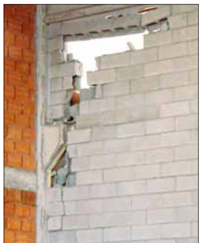
Figura 6.10: Esempi di fessurazione di pannelli di tamponatura interni (terremoto Emilia-Romagna 2012, Mirandola (MO))
