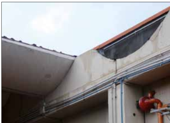
Figura 5.27: Perdita d'appoggio di un tegolo di copertura per mancanza di connettori sismici e insufficiente lunghezza d'appoggio. Livello di danno nella connessione copertura-trave: D5 (terremoto Abruzzo 2009).
