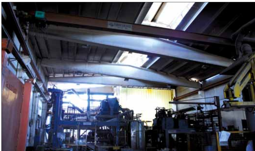
Figura 5.22: Perdita d'appoggio delle travi di copertura di un capannone prefabbricato monopiano. Livello di danno nella connessione trave-pilastro: D4 - D5 (terremoto Emilia-Romagna 2012, San Felice sul Panaro, MO)
