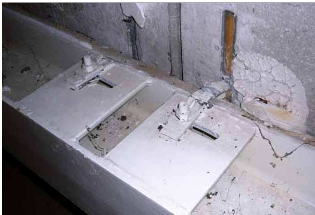
Figura 5.37: Danneggiamento del collegamento faccia orizzontale – faccia verticale fra un pannello e la trave di copertura: fessurazione nel calcestruzzo e rottura dei connettori metallici. Livello di danno nella connessione pannello-struttura: D4 - D5 (terremoto Abruzzo 2009).
