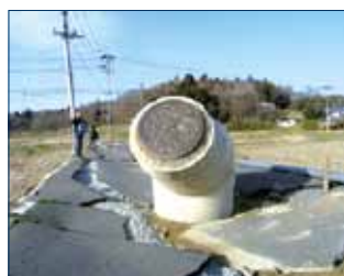
Figura 7.9: Sollevamento di un tombino e contemporanea subsidenza del terreno con pesante danneggiamento del manto stradale a Sukagawa di Fukushima (Giappone 2011)
