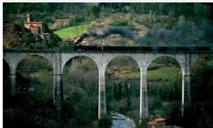
Treno a Vapore sul viadotto Villetta a Camporgiano (Foto di Pietro Guidugli - Archivio fotografico Regione Toscana)
