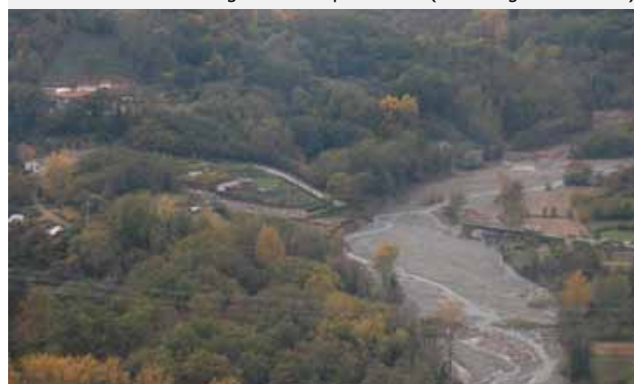
Effetti dell'alluvione dell'Ottobre 2011: ponte distrutto dalla piena sulla SP 32 (fonte Regione Toscana)
