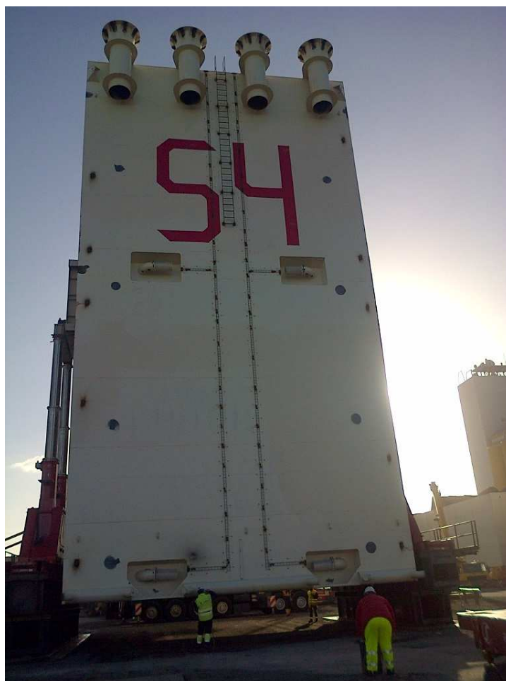
Rotazione del cassone S4 presso il cantiere di Livorno
