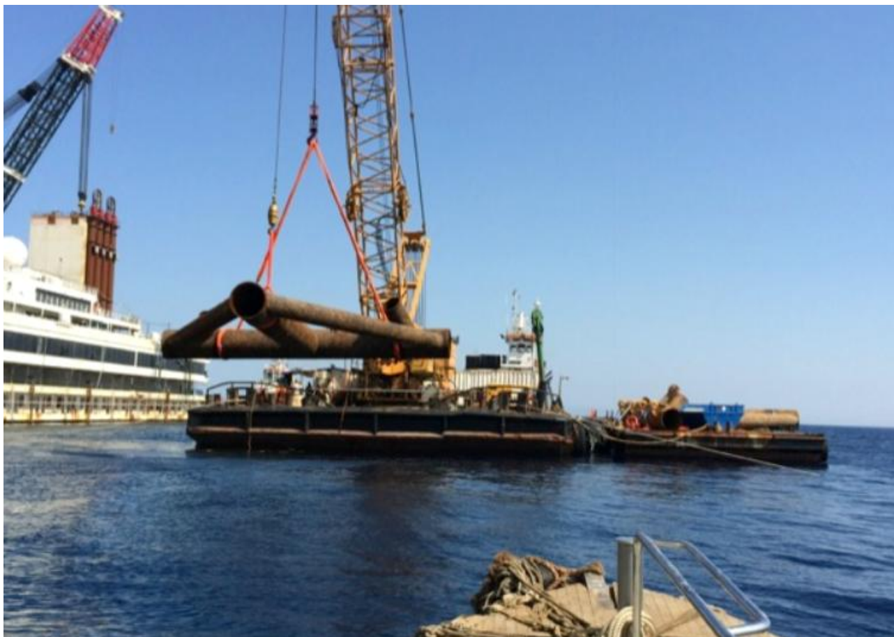
Sopra: Rimozione tubolari (pull bar) della piattaforma 1
