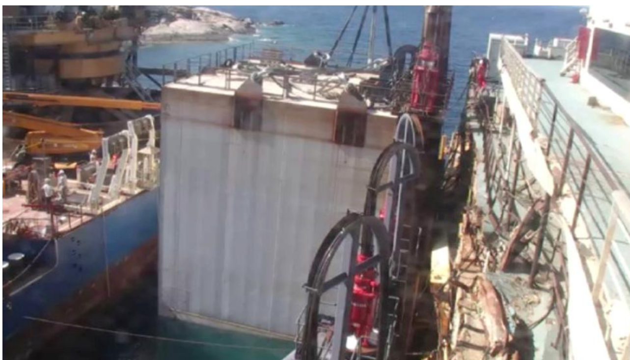
Sopra: Rimozione tubolari (pull bar) della piattaforma 1
