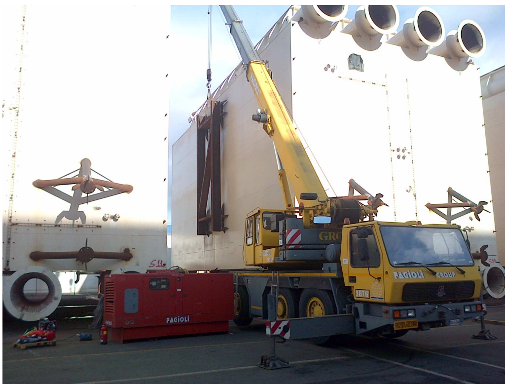
Installazione supporti per la rotazione sul cassone S10 Sotto: riavvio attività nel cantiere di Livorno
